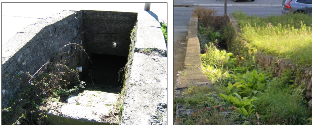
Imbocco sottopasso S.P. e situazione generale dell'ultimo tratto d'asta
