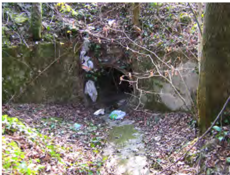
Imbocco tratto intubato in via Monte Basso
