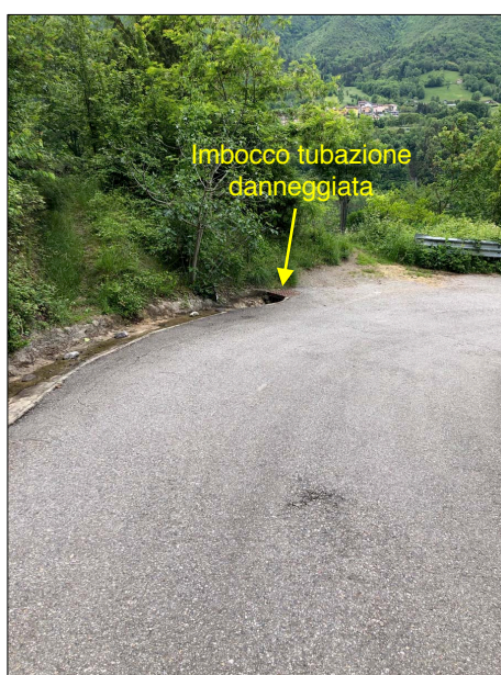
Imbocco della rete delle acque bianche lungo la strada a monte di via San Bernardino
