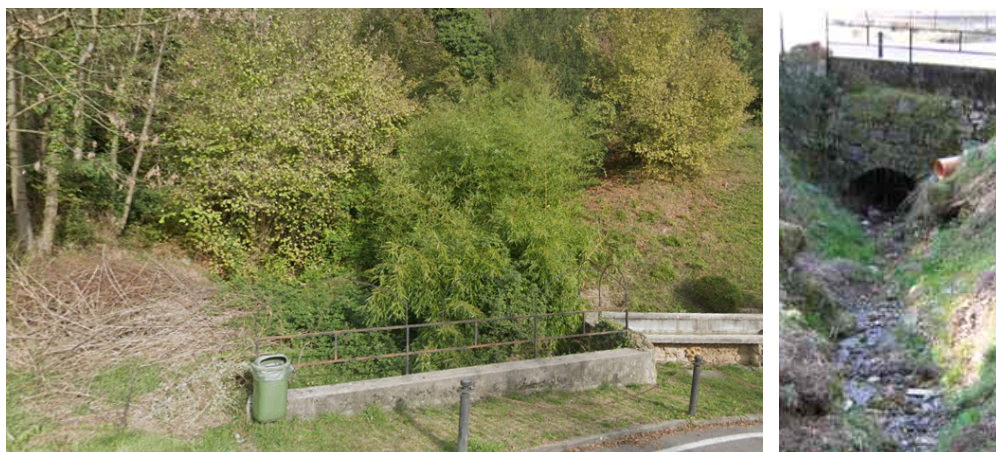
Sottopasso ponte strada per Sottoripa - lato di monte
