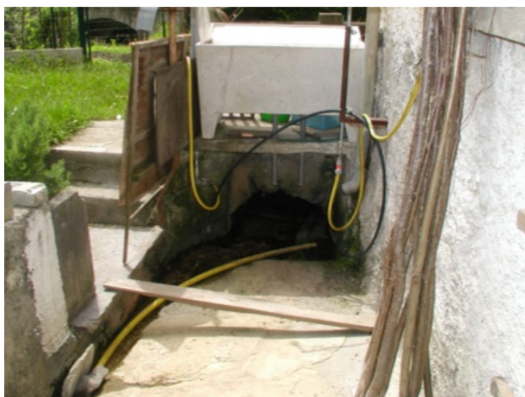
Tratto d'alveo incanalato/coperto
