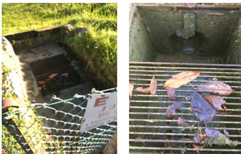
Imbocco tratto intubato e particolare dell'opera
