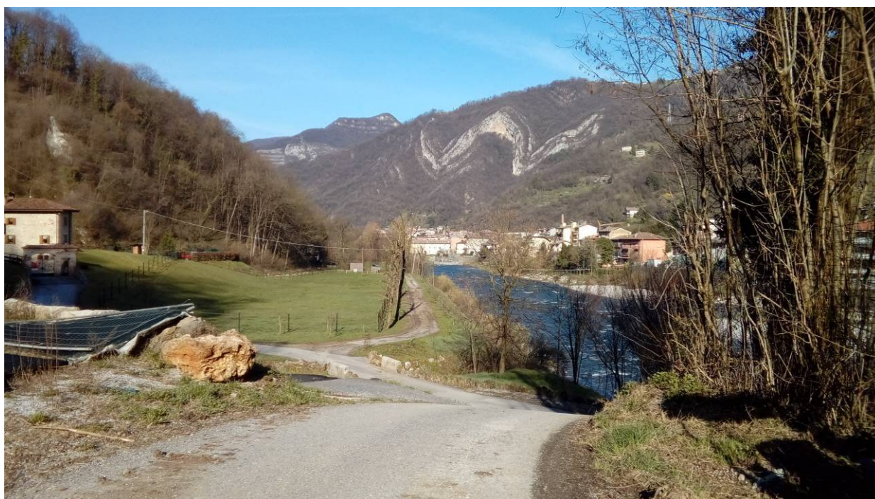
Foto 2: panoramica area a valle vista della proprietà, si noti la differenza di quota non apprezzata dalle sezioni idrauliche del PAI PGRA
