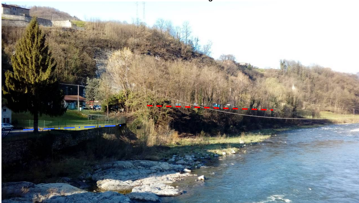
Foto 1: panoramica area in esame vista dal ponte a monte
