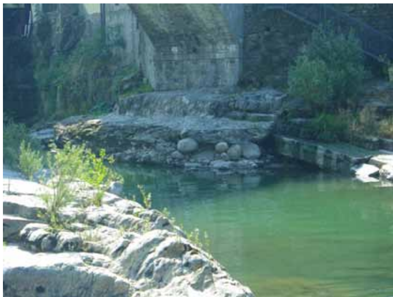
Dettaglio del piede della spalla in sinistra idrografica
