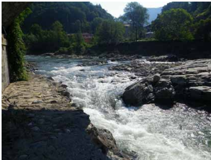
Alveo in corrispondenza del Ponte Vecchio
