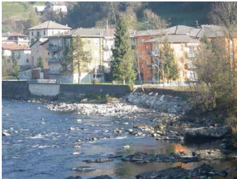
Tratto sponda sinistra, vista da valle
