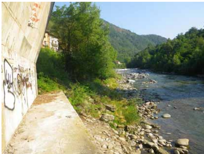
Base della pila in destra idrografica
