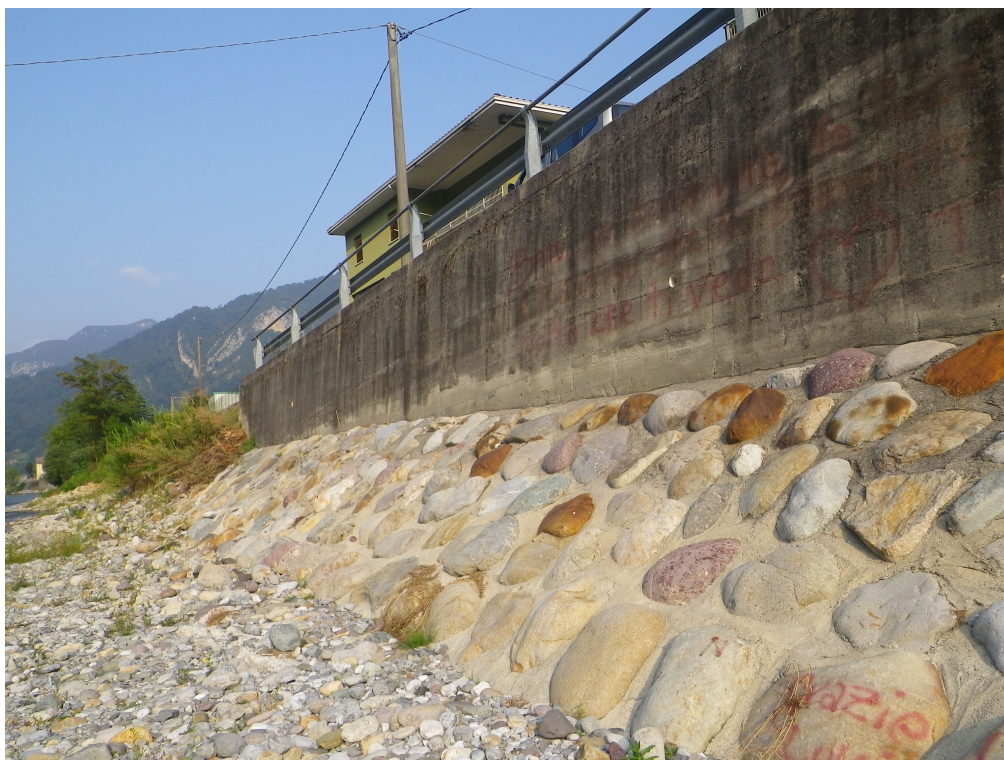
BR03 – Muro in cls senza sopralzo protetto al piede da ciottoli e blocchi annegati nel cls
