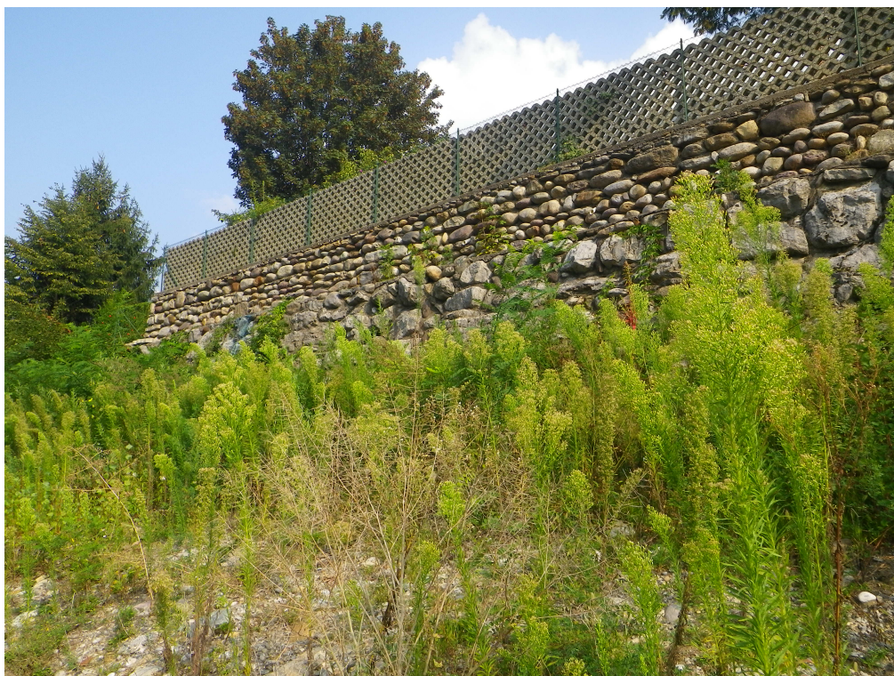
BR01 – Muro in sassi e cemento su scogliera in massi ciclopici
