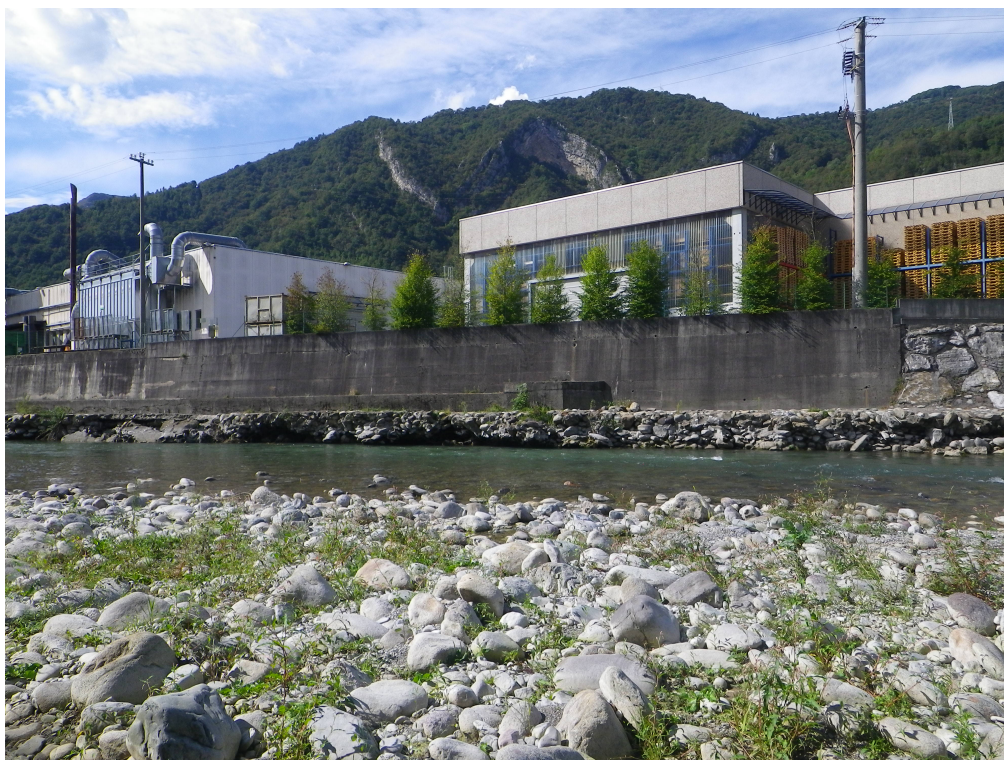
BR011 – Muro in cls con sopralzo non protetto al piede (evidente l'erosione al piede del manufatto)
