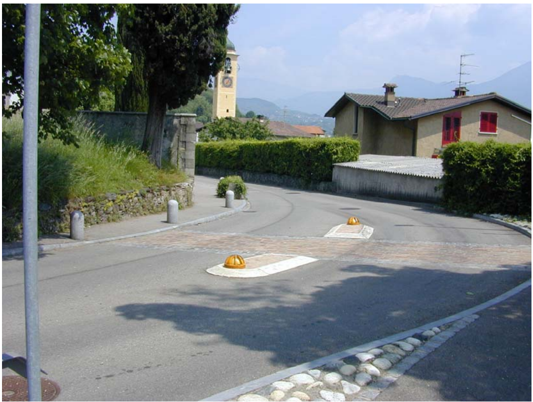
figura 8-9 – esempi di interventi realizzati
