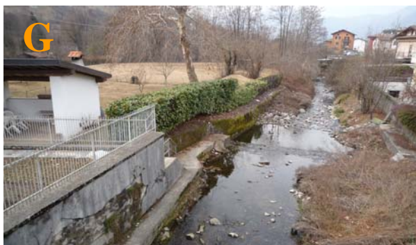
Difese spondali e opere trasversali: in alto torrente Albina (A e B), seguono vasca di sedimentazione dei torrente Brandena (C) e Cornello (D); briglie lungo la valle del monte Rena (E), diga di sbarramento sul Serio (F) e difese spondali sul torrente Luio (G e H)
