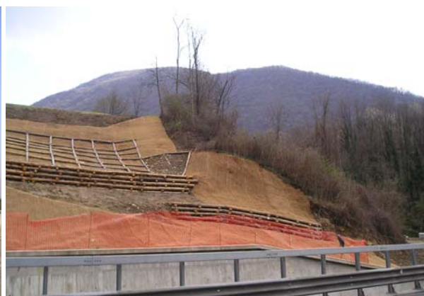
Palificate, geostuoie e grate camera in località Dossi
