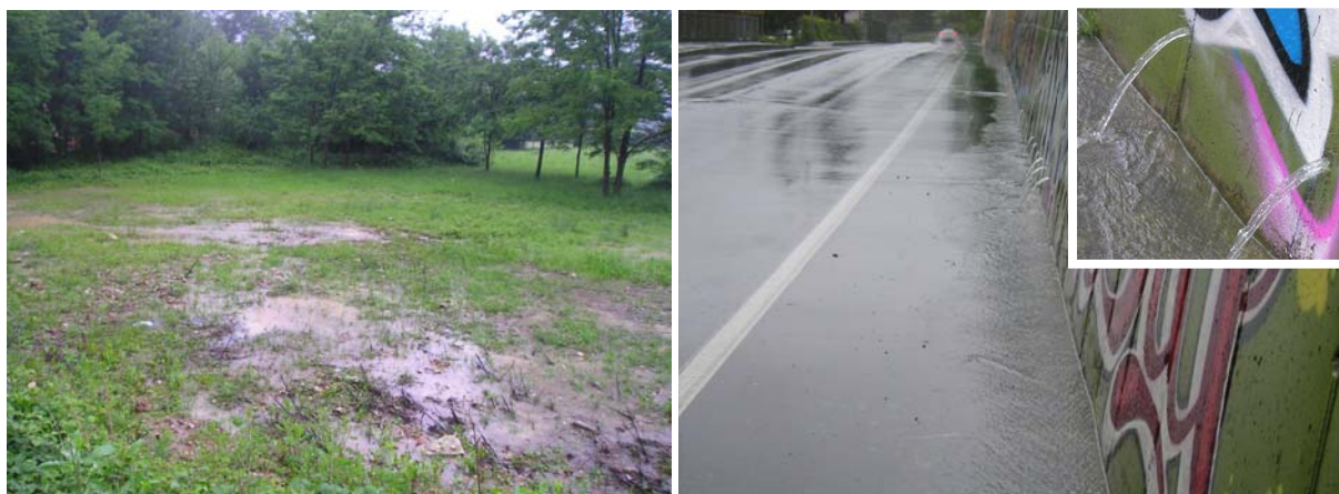
Via Pradella: ristagno d'acqua, emersione della falda e venute d'acqua dal muro di sostegno della strada.
