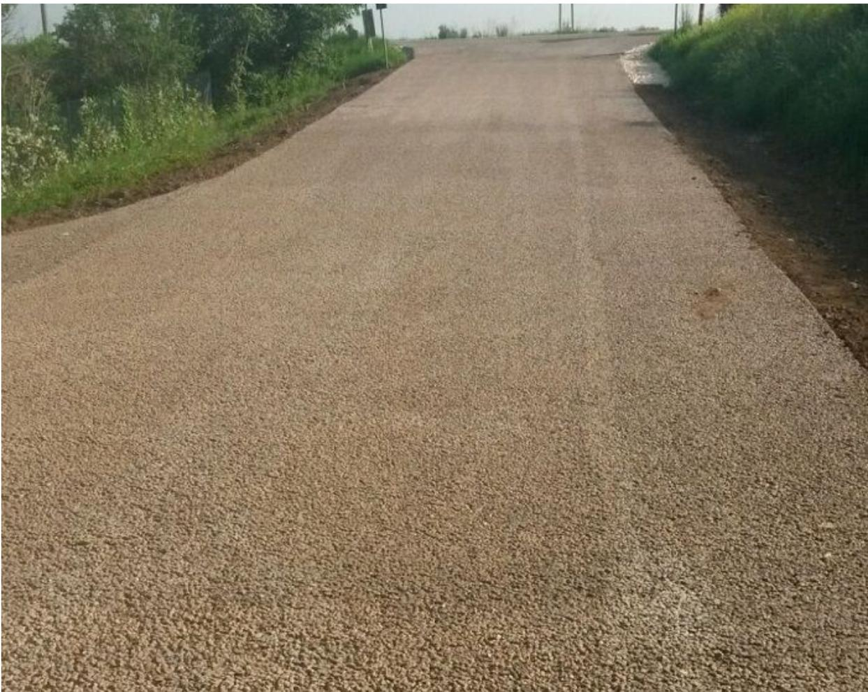
Materiale inerte stabilizzante per il percorso stradale / accesso
