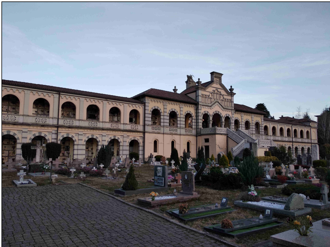
F. 04 – Vista Prospettica Arcate Interne
