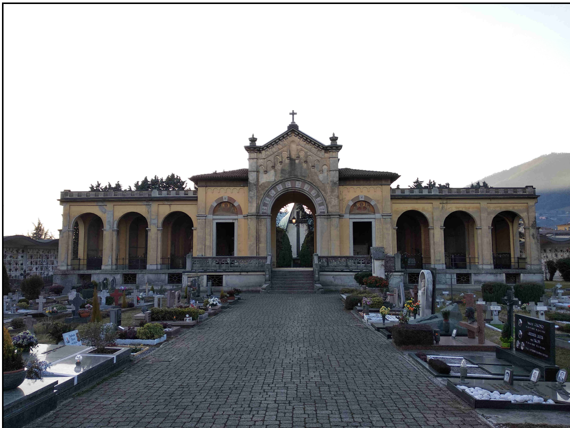
F. 10 – Vista Monumento Centrale
