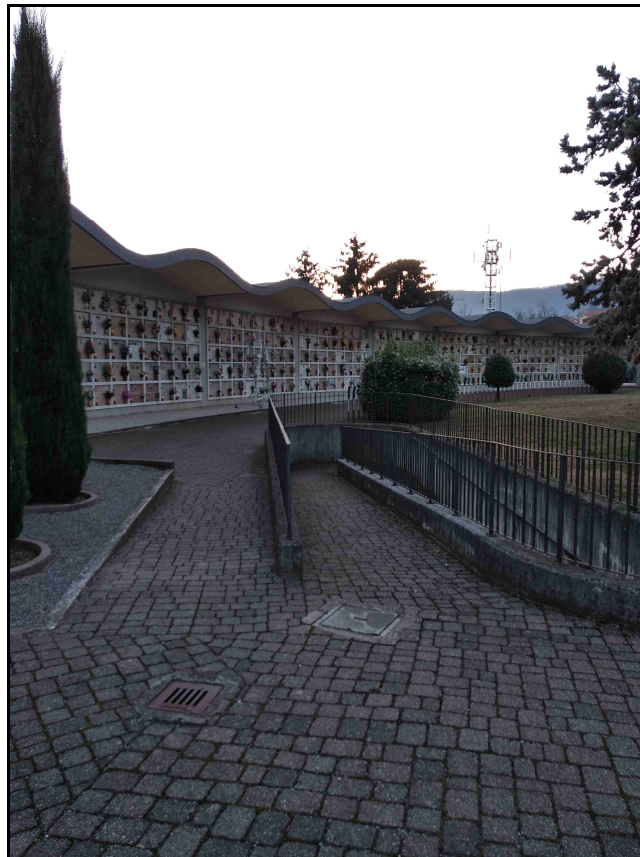
F. 25 – Vista Rampa per Disabili lato Sud
