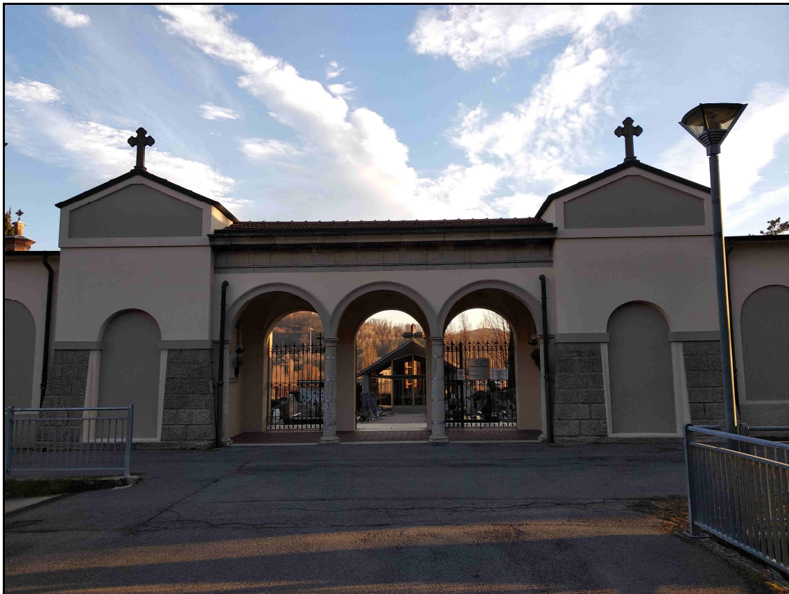
F. 01 – Vista Ingresso dall'esterno
