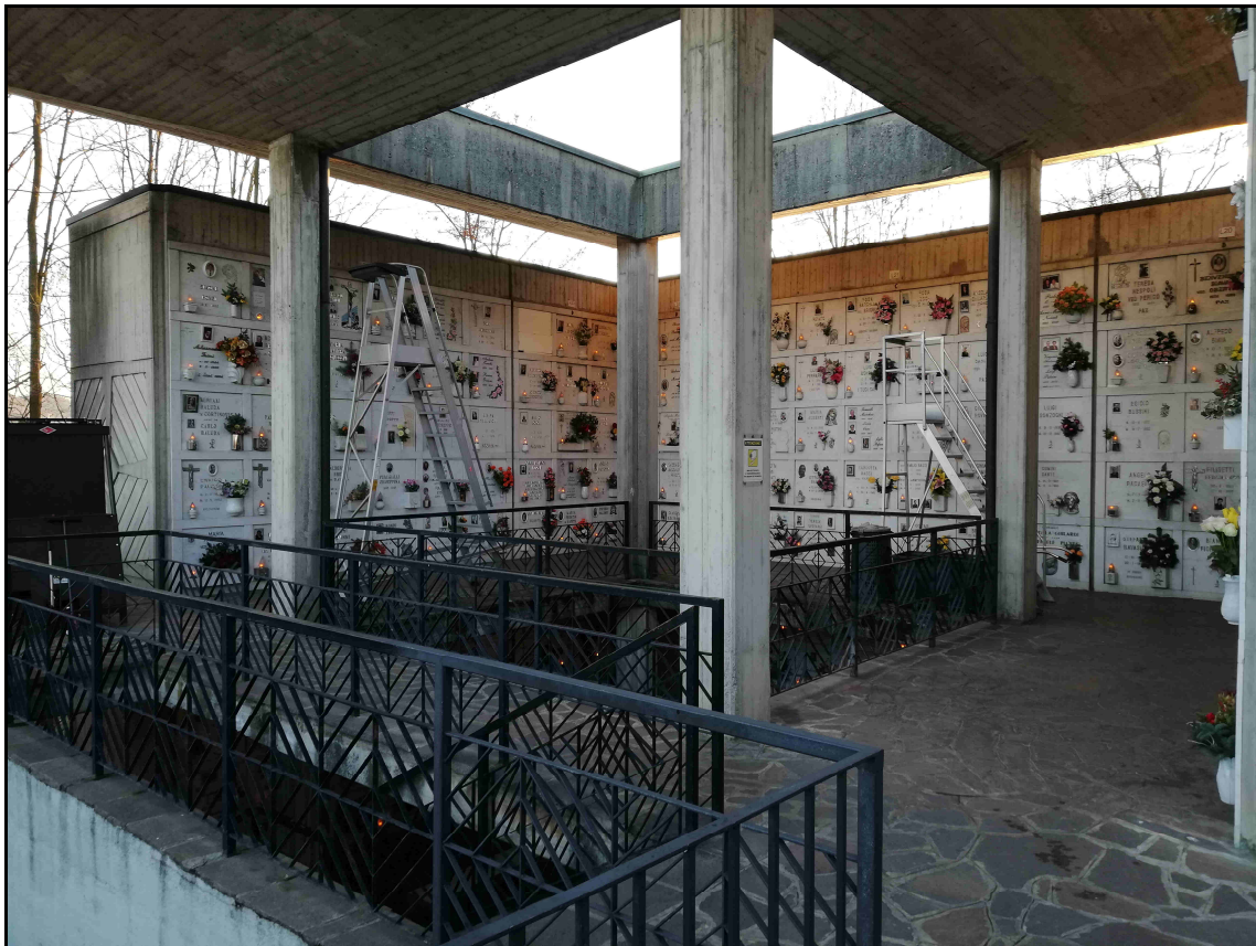
F. 25 – Vista Loculi L20-L24 Piano Terra
