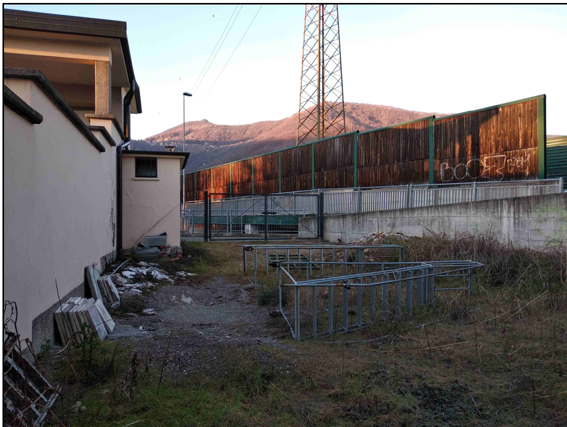
F. 03 – Vista Area di Deposito
