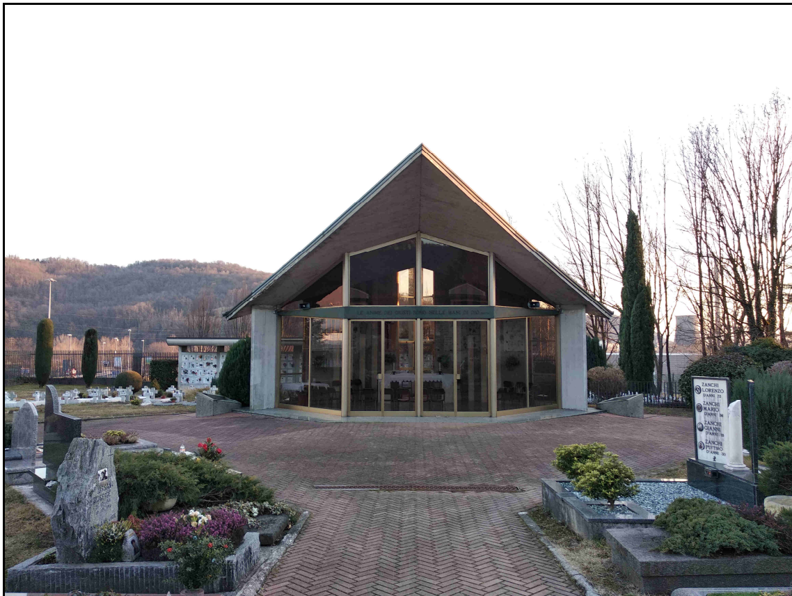
F. 19 – Vista Facciata Anteriore Chiesetta
