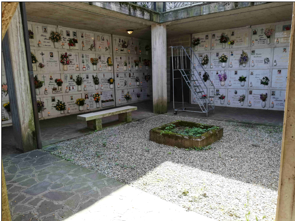
F. 26 – Vista Loculi L20-L24 Piano Interrato e Giardinetto
