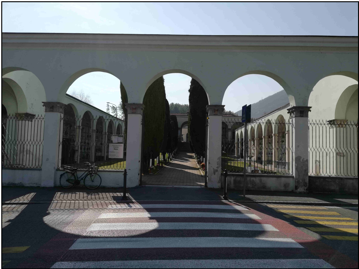
F. 01 – Vista Ingresso dall'esterno
