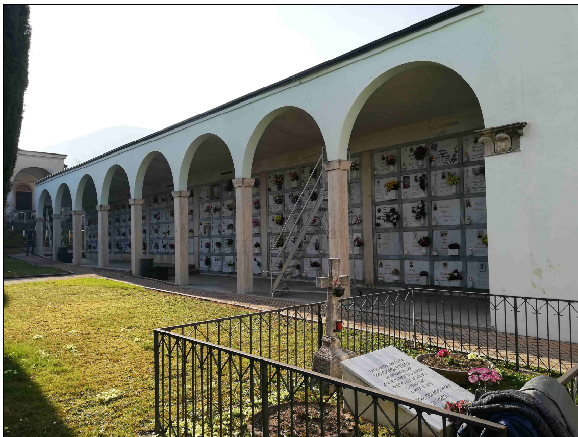
F. 06 – Vista Arcate e Loculi L1-L6
