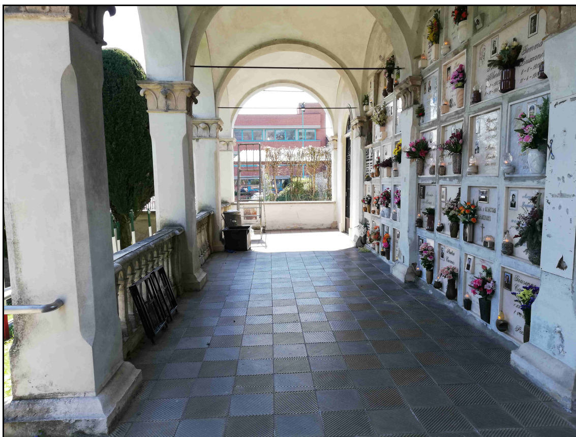
F. 14 – Vista Arcate e Loculi L15-L16
