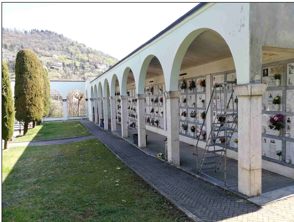
F. 08 – Vista Arcate e Loculi L7-L12
