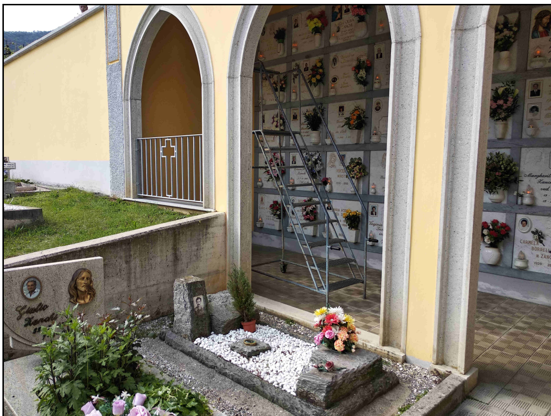
F. 08 – Vista Arcate e Loculi L1-L2
