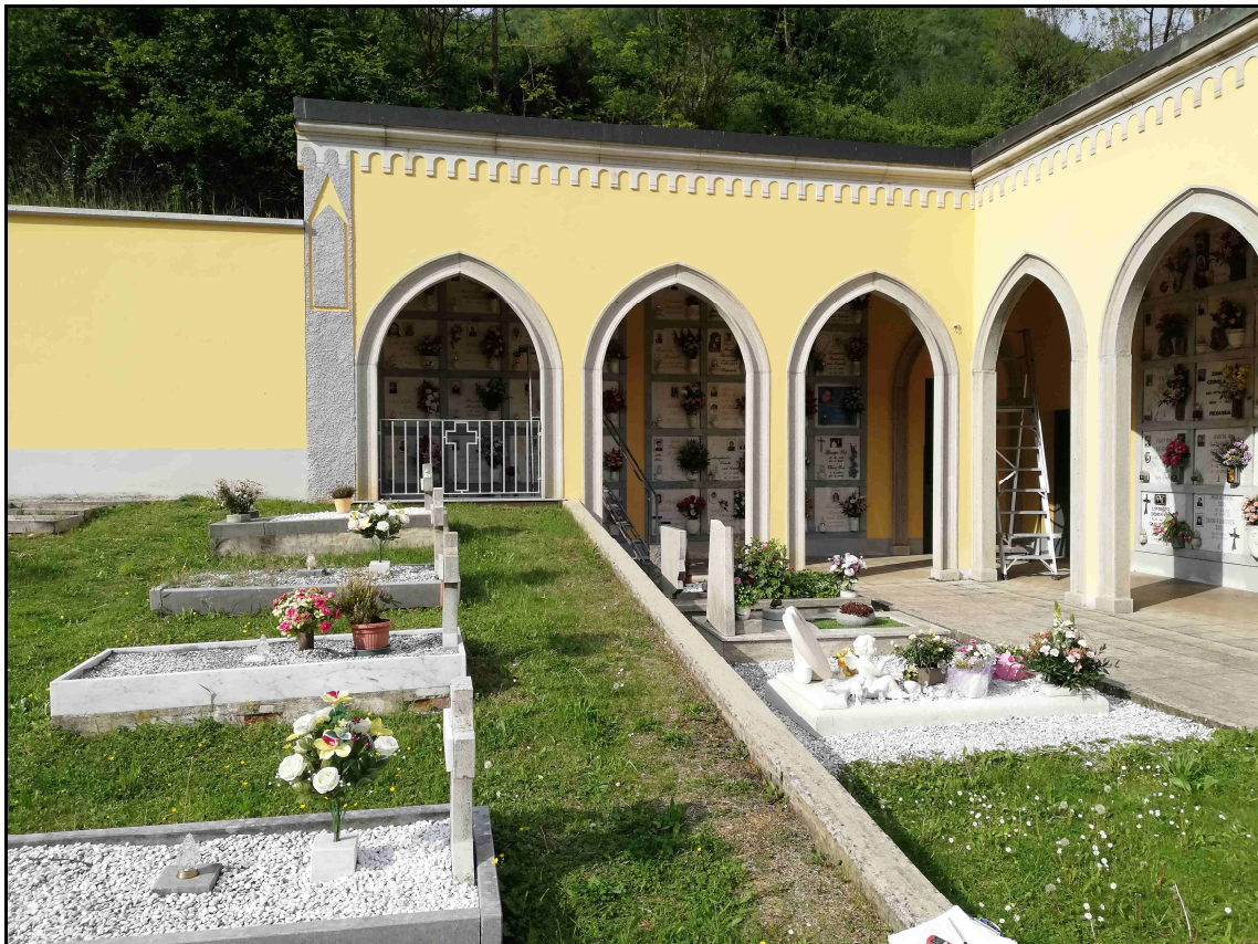
F.06 – Vista Arcate e Loculi L5-L6
