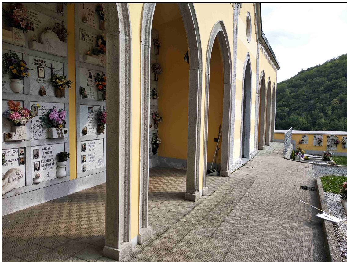
F. 07 – Vista Arcate e Loculi L3-L4
