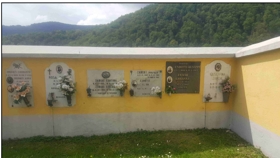
F. 10 – Vista Lapidi su muro di recinzione
