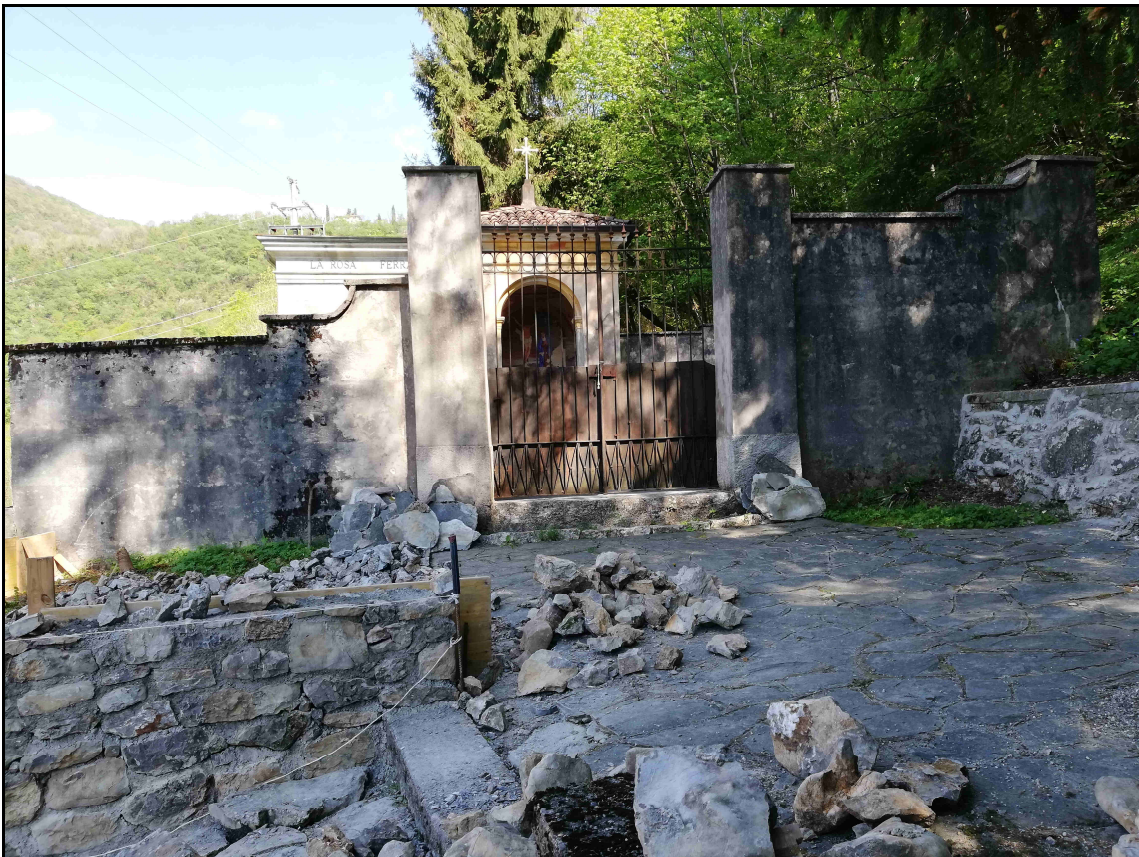
F. 01 – Vista Ingresso dall'esterno
