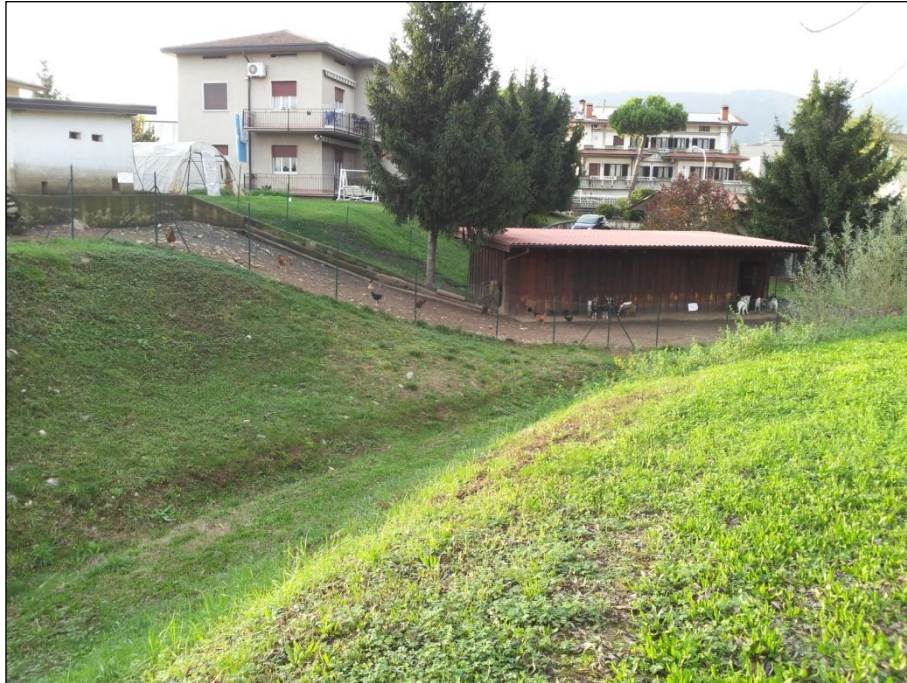
Figura 3 - L'ex canale posto come limite di fascia B: si evidenzia il dislivello altimetrico tra le due sponde
