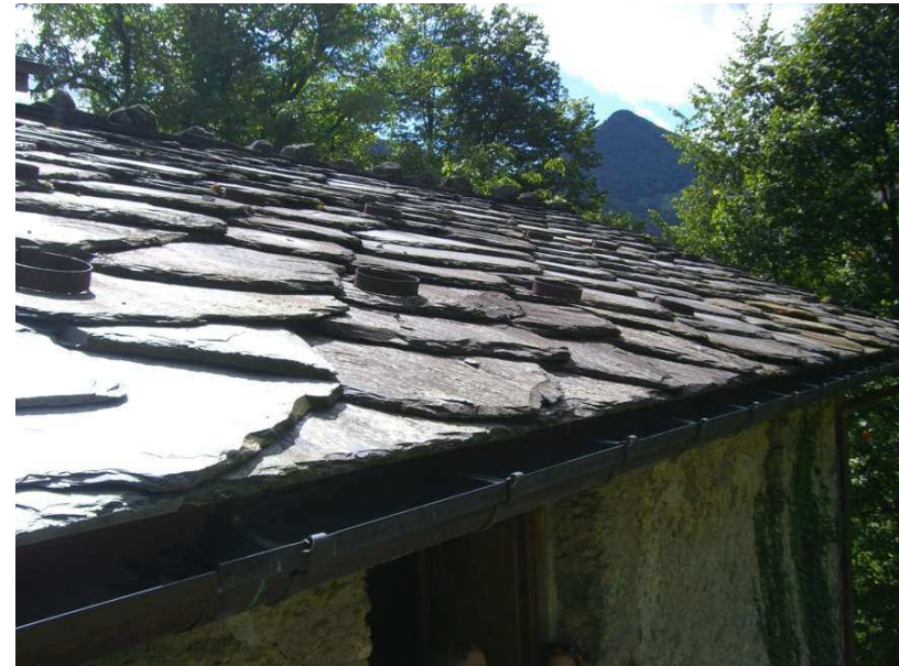
Figura 3-136: Particolare di tetto a piode
