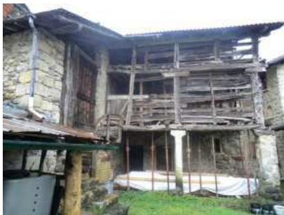
Figura 3-85: Edificio tradizionale con pilastri in pietra e ballatoi esterni lignei
