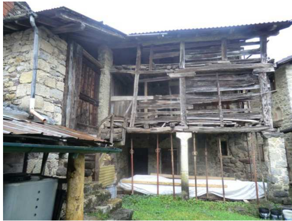
Figura 3-49: Edificio tradizionale con pilastri in pietra e ballatoi esterni lignei
