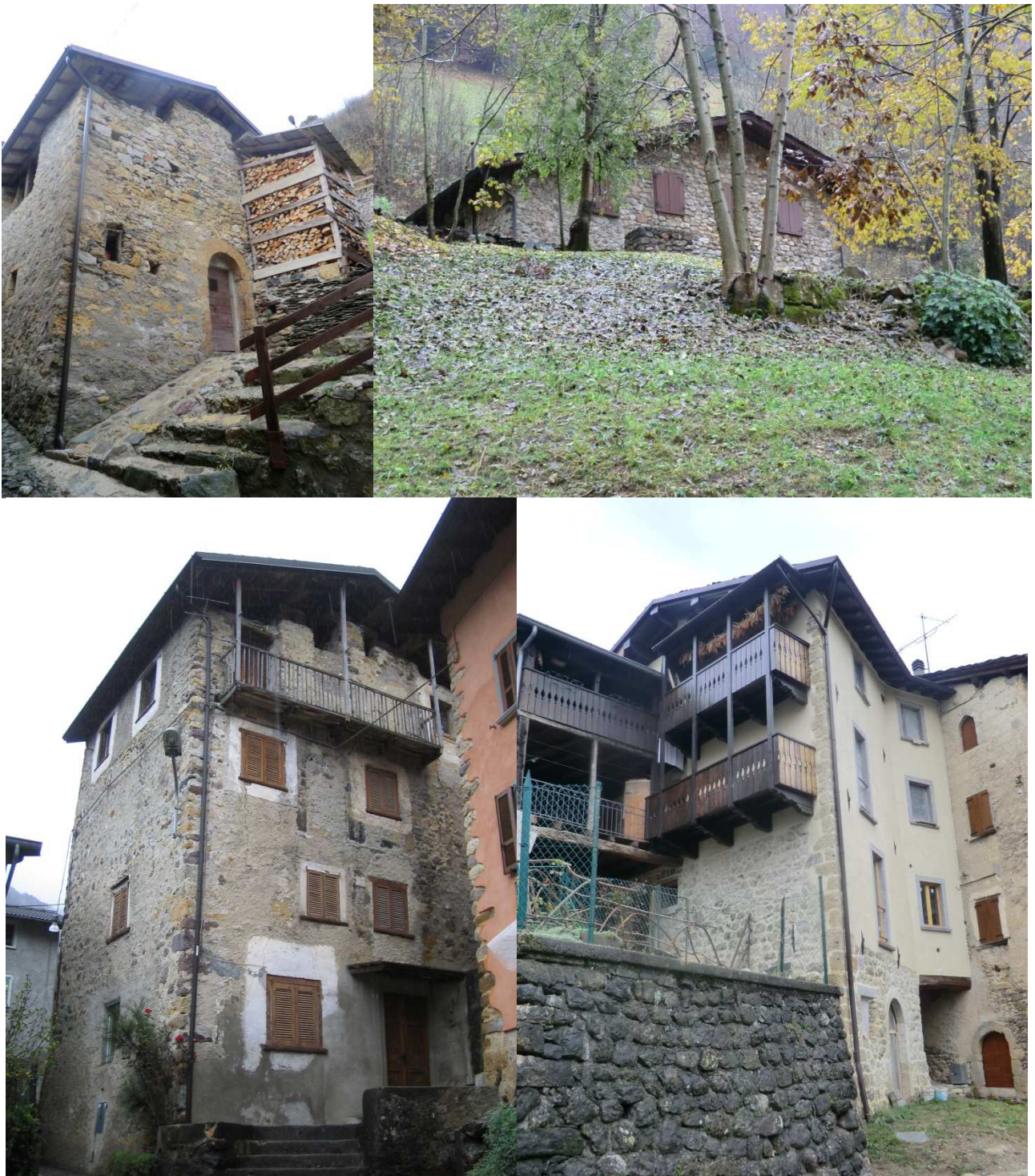
Figura 4-35: Esempi di edificio in pietra
