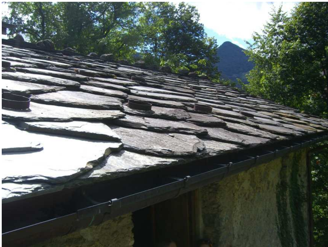
Figura 4-30: Particolare di tetto a piode
