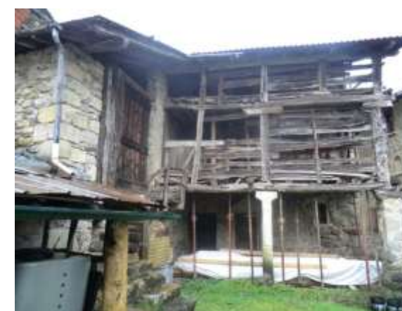
Figura 5-84: Edificio tradizionale con pilastri in pietra e ballatoi esterni lignei
