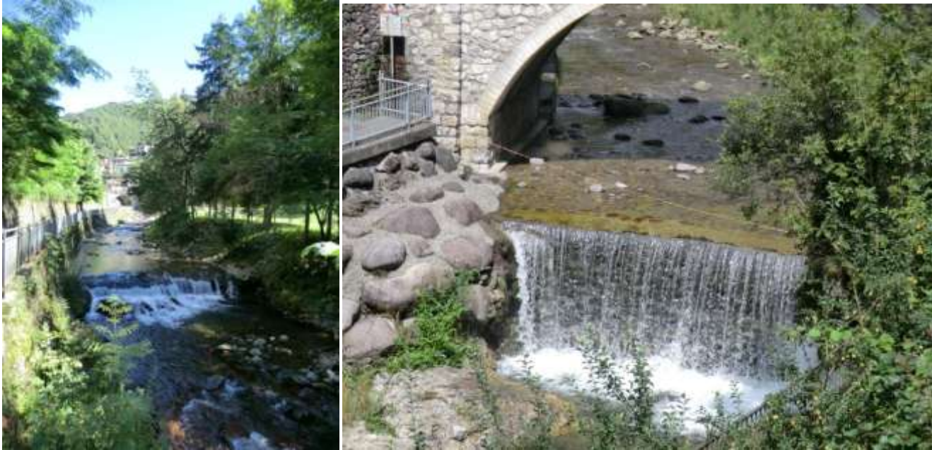
Figura 5-15: immagini del tratto del Torrente Mora in località Averara (a sinistra) e particolare del salto del torrente sotto il ponte ad Averara centro (destra).
