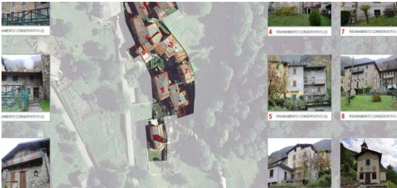
Figura 5-102: Gradi di intervento nei fabbricati del centro storico di Valmoresca
