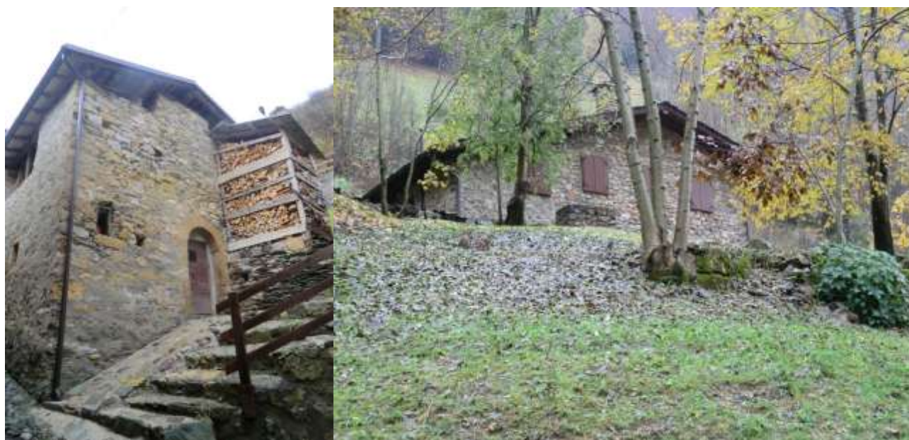
Figura 5-139: Esempi di edificio in pietra
