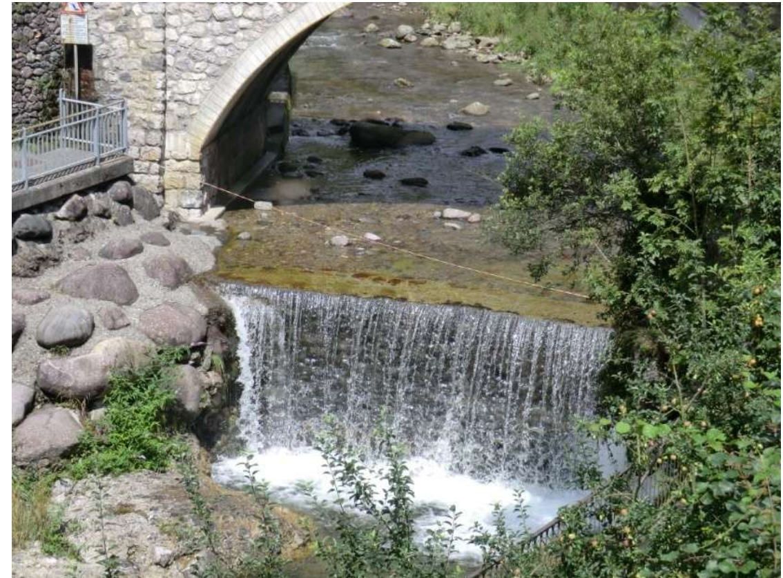
Figura 5-45: Particolare del salto del torrente sotto il ponte ad Averara
