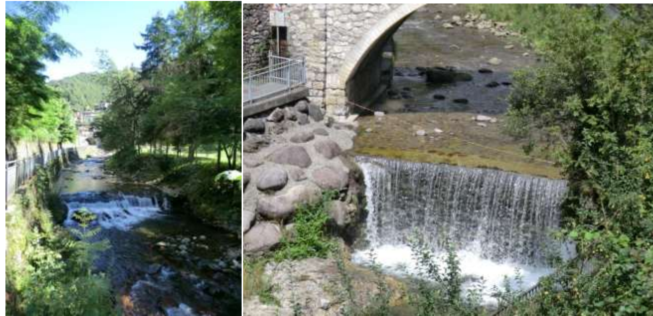
Figura 4-9: immagini del tratto del Torrente Mora in località Averara (a sinistra) e particolare del salto del torrente sotto il ponte ad Averara centro (destra).
