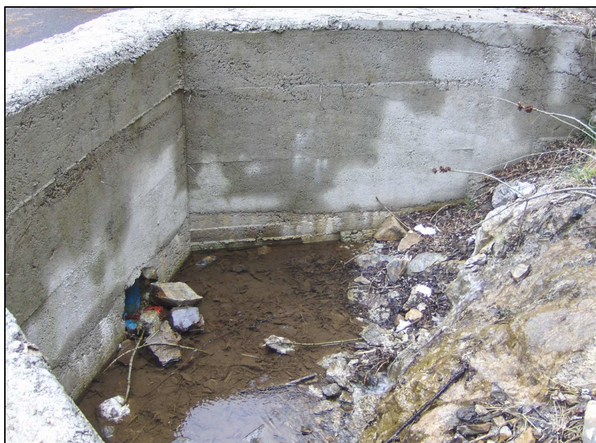
Foto 5: tombinatura del Rio delle Costa a monte dell'attraversamento stradale.
