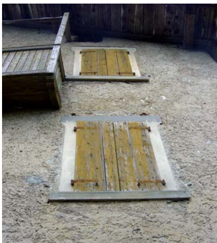
n. 8 (dettaglio fronte sud)
