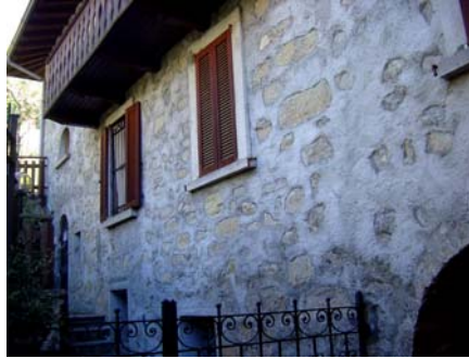
n. 1 lato ovest
