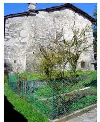
n. 3 (lato est)
