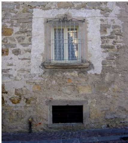
n. 1 (finestra con intonaco)
