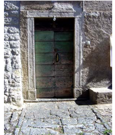
n. 10 (dettaglio portale in pietra)
