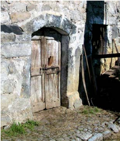
n. 10 (dettaglio portale in pietra)
