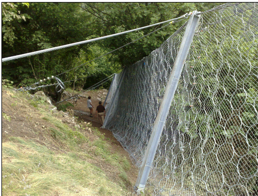
Figura 10: reti paramassi a monte della strada verso Aviatico, località Trafficienti
