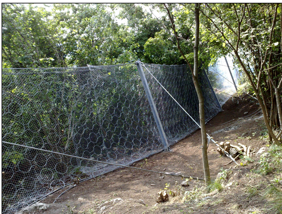
Figura 11: reti paramassi a monte della strada verso Aviatico, località Trafficienti
