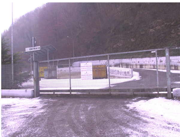
Foto 7: Accesso della piazzola ecologica di via Tiberio.
