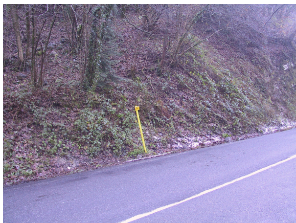
Foto 9: Palo di segnalazione della linea del metano lungo la S.P. 28
