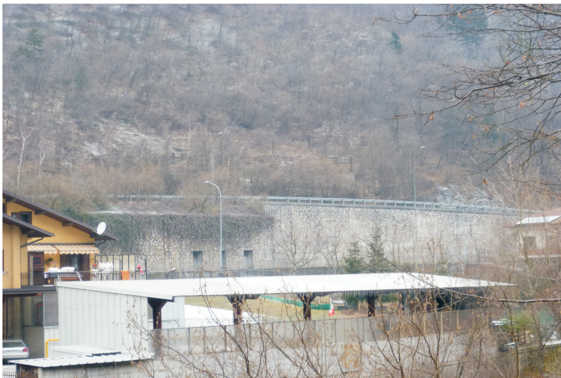
Foto n° 7: Berriere paramassi in legname a monte della S.P. 471 - svincolo di Lenna
