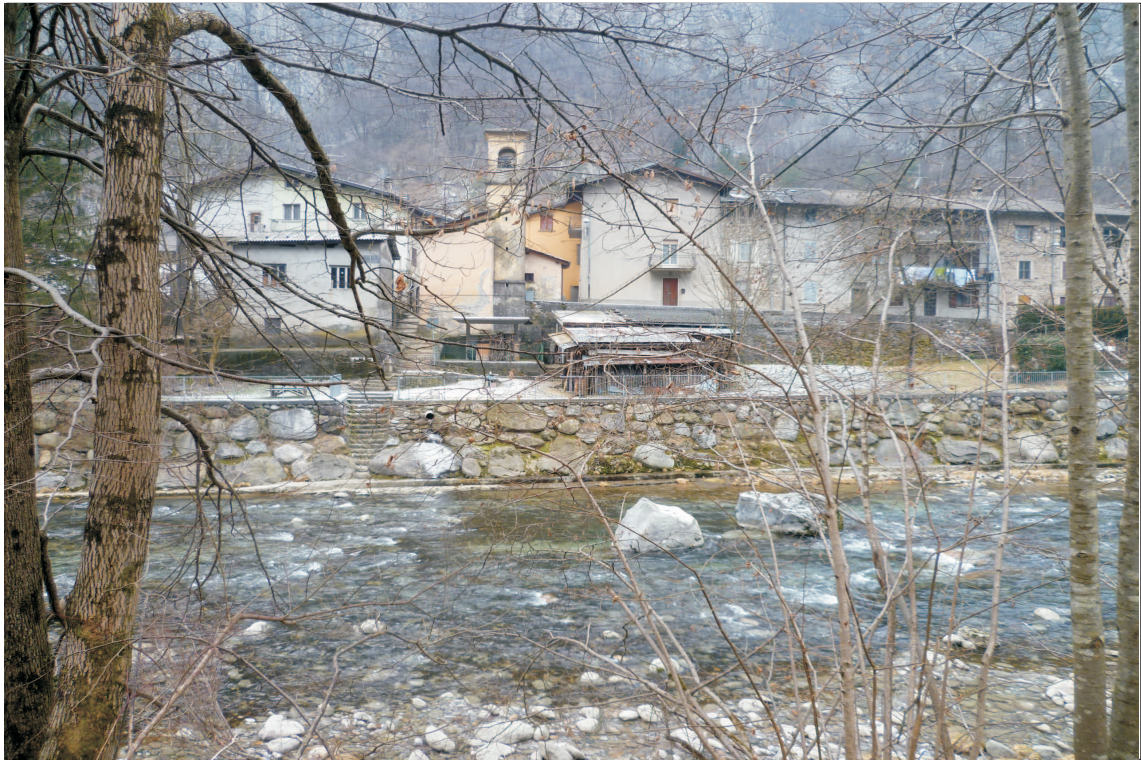
Foto n° 5: Difese spondali sul fiume Brembo in sponda destra - loc. Scalvino
