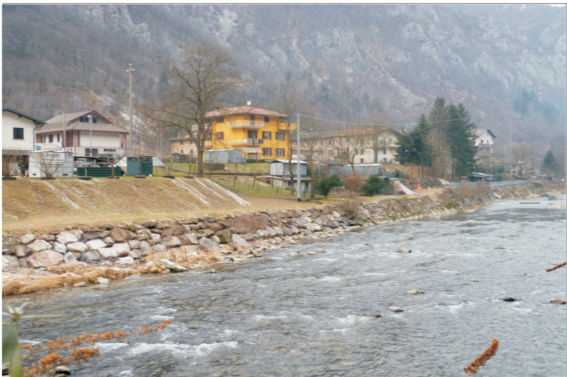
Foto n° 6: Difese spondali sul fiume Brembo in sponda destra - loc. Scalvino
