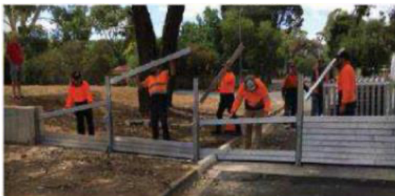
Barriera temporanea modulare con pilastri e panconi manuali in alluminio
