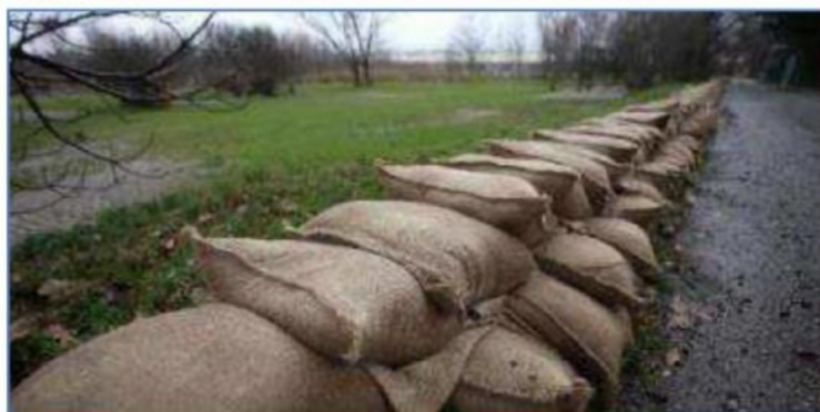
Barriera temporanea antiesondazione in sacchi di sabbia
