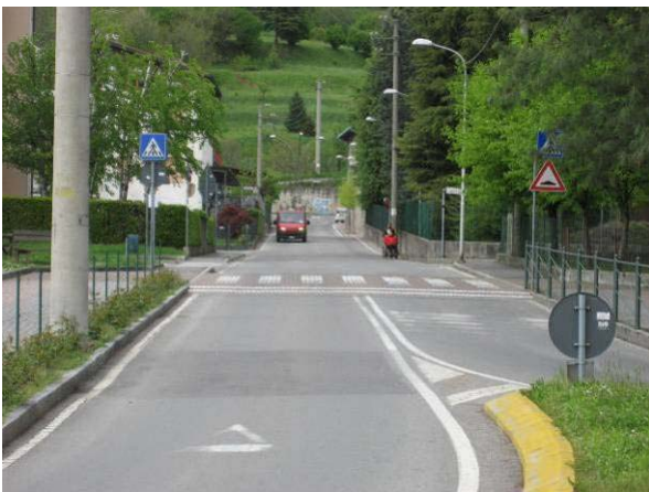
L'attraversamento su via Puccini Manca il segnale di posizione di attraversamento ciclabile
