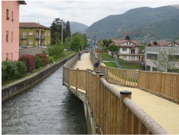
Imbocco della ciclabile della Seriola da Alzano
