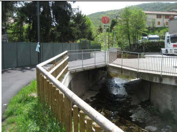
Sbalzi sul torrente
