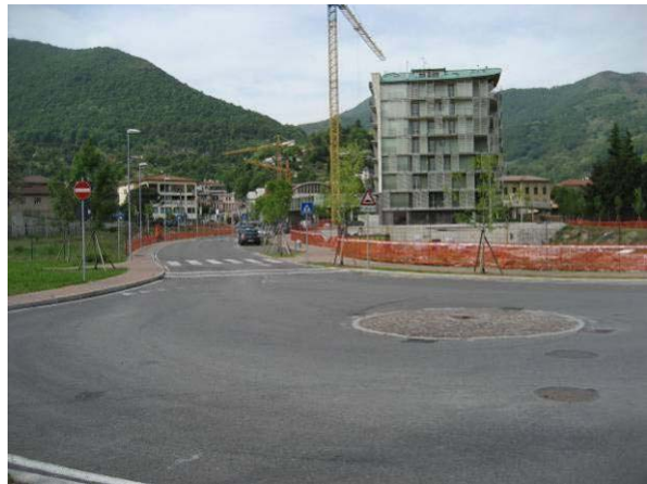
La nuova strada che porta alla stazione TEB
