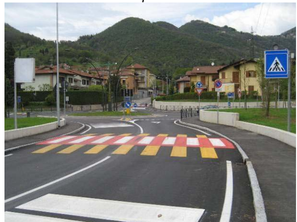
Un attraversamento pedonale leggermente rialzato
