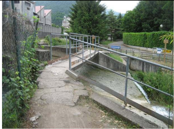
Il collegamento verso il fiume su delle vecchie passerelle pedonali
