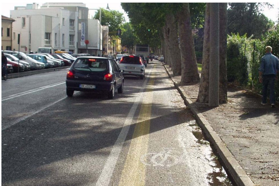
Monodirezionale in corsia ciclabile delimitata da segnaletica longitudinale
