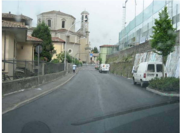
A destra manca il marciapiede
