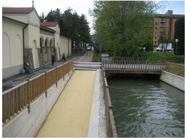
Il proseguimento verso Alzano ancora da completare
