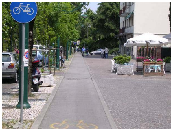
Monodirezionale a quota marciapiede
