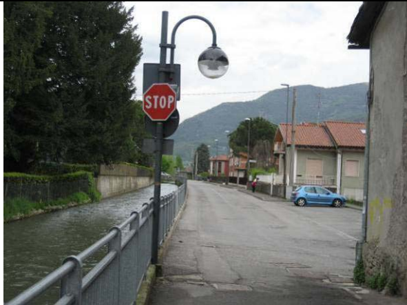
Sbocco in via Rotone ove la ciclabile termina
