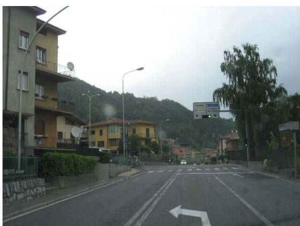
Accesso a Via Tasso da provinciale
