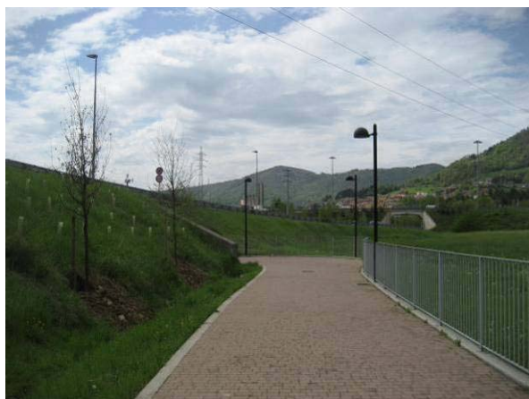
La ciclabile sottopassa la superstrada
