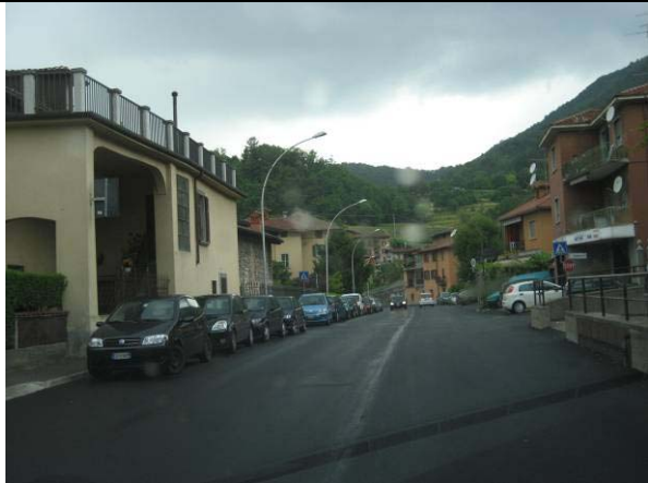
A destra manca il marciapiede
