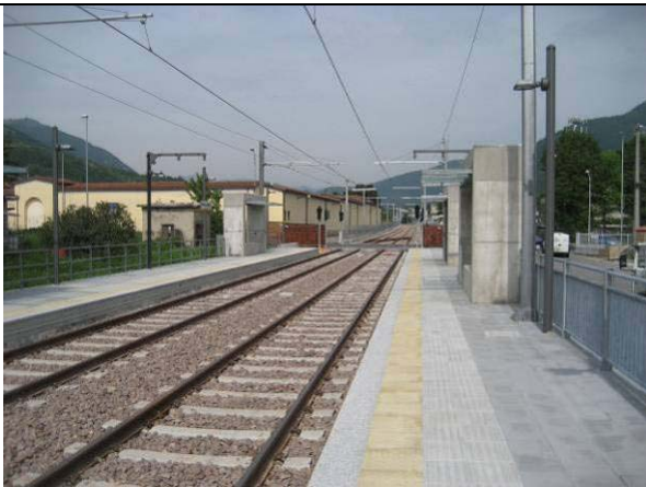
Le nuova stazione TEB con pensiline insufficienti e senza spazio per il deposito bici
