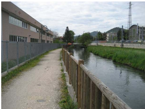
Prosecuzione verso sud lungo la Seriola ...
