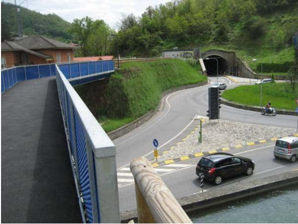
La passerella sulla provinciale 85
