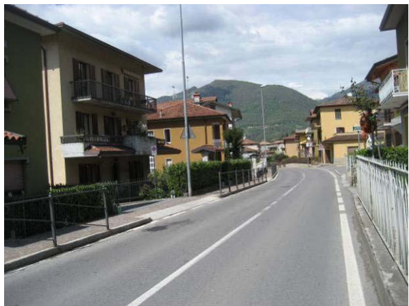
La strada di Gavarno con un solo marciapiede tutto delimitato da parapetto metallico
