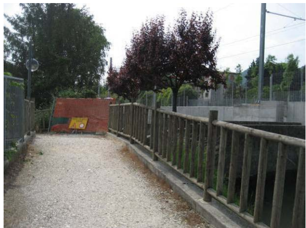
... fino al blocco costituito dalla TEB
