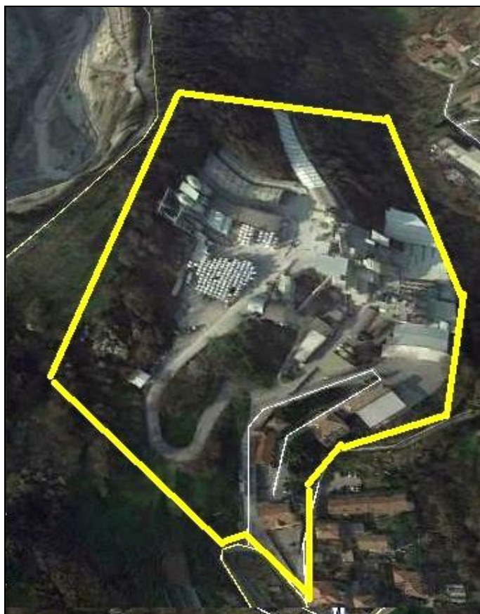
Ambito P1 Produttivo consolidato con attività di Cementeria
