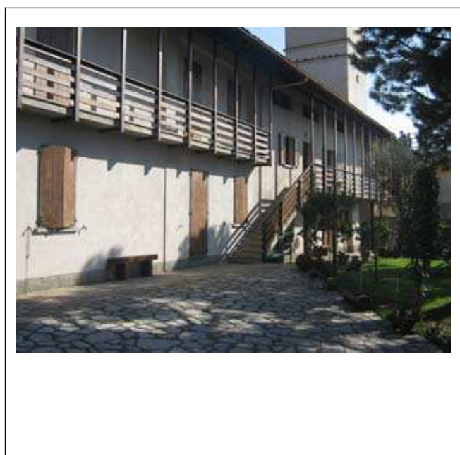
DOCUMENTAZIONE FOTOGRAFICA Vista panoramica di contesto
