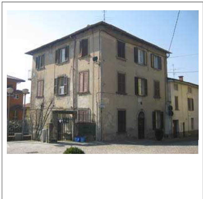
DOCUMENTAZIONE FOTOGRAFICA Vista panoramica di contesto
