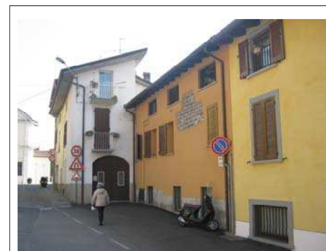
DOCUMENTAZIONE FOTOGRAFICA Vista panoramica di contesto
