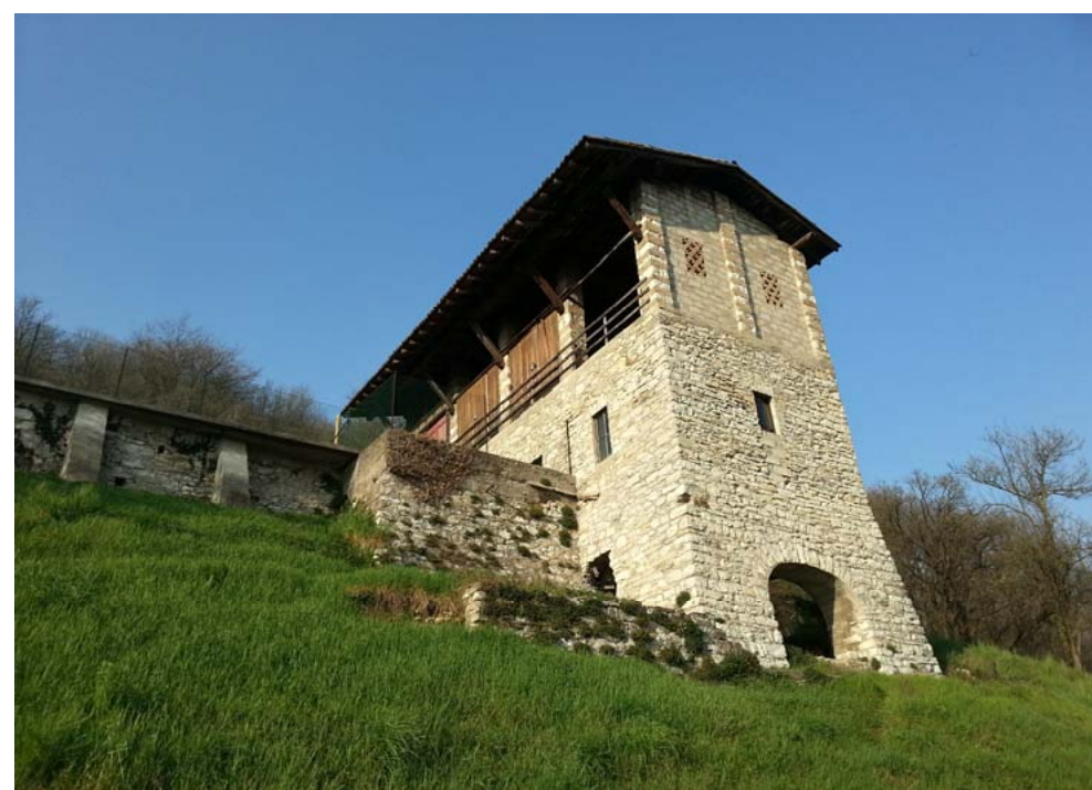
DOCUMENTAZIONE FOTOGRAFICA VISTA panoramica di contesto
