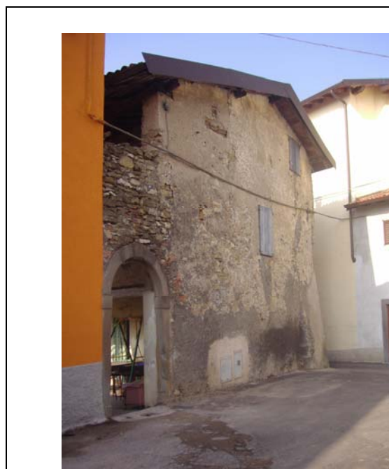
DOCUMENTAZIONE FOTOGRAFICA VISTA panoramica di contesto
