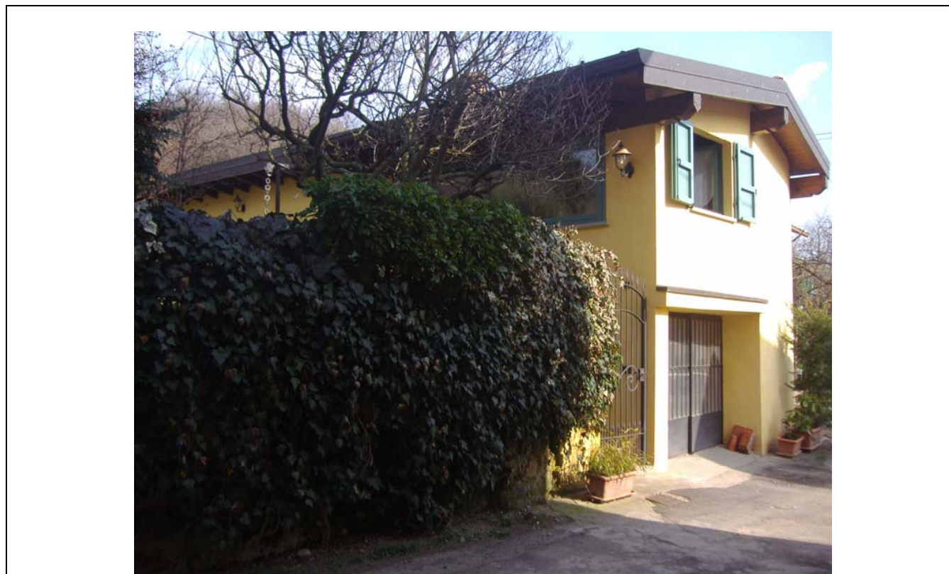
DOCUMENTAZIONE FOTOGRAFICA VISTA panoramica di contesto
