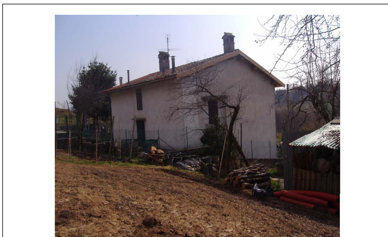
DOCUMENTAZIONE FOTOGRAFICA VISTA panoramica di contesto
