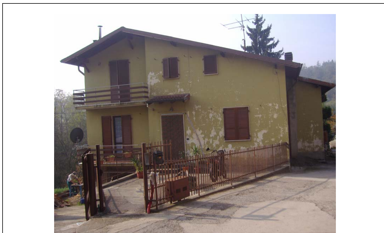
DOCUMENTAZIONE FOTOGRAFICA VISTA panoramica di contesto
