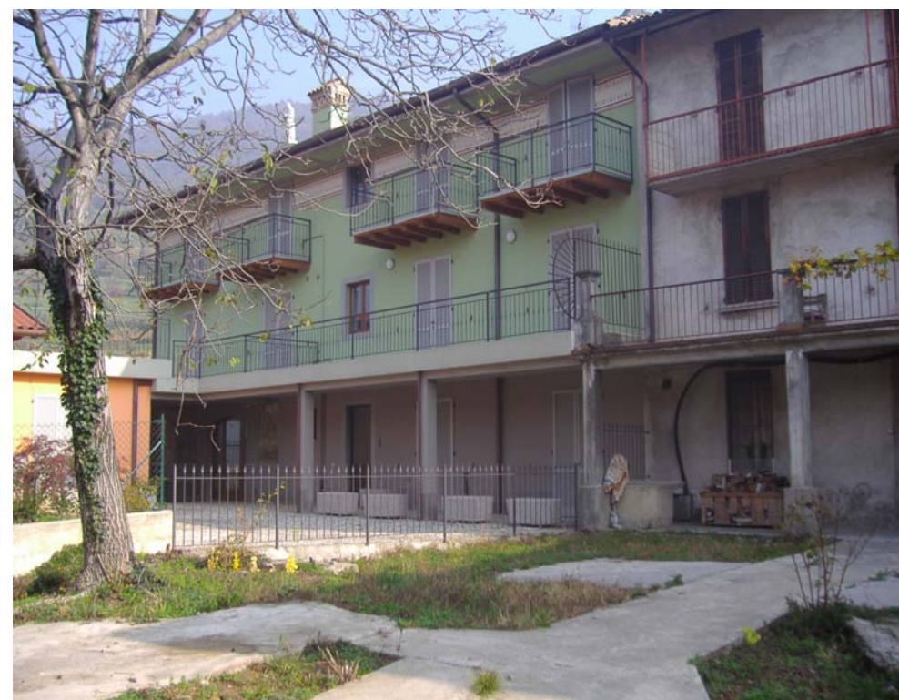
DOCUMENTAZIONE FOTOGRAFICA VISTA panoramica di contesto
