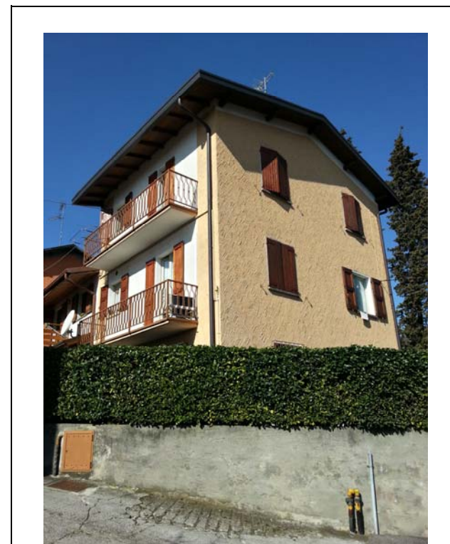
DOCUMENTAZIONE FOTOGRAFICA VISTA panoramica di contesto
