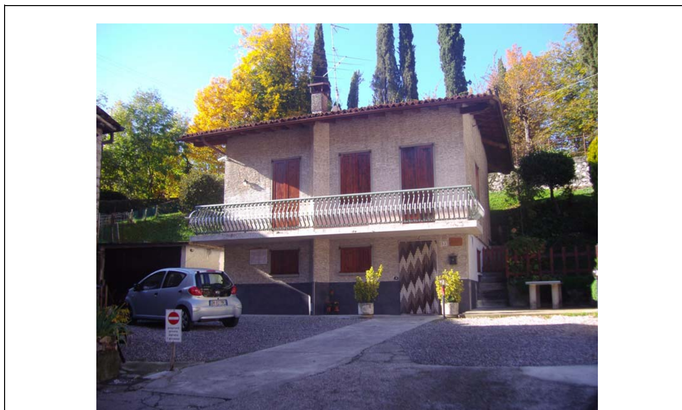
DOCUMENTAZIONE FOTOGRAFICA VISTA panoramica di contesto
