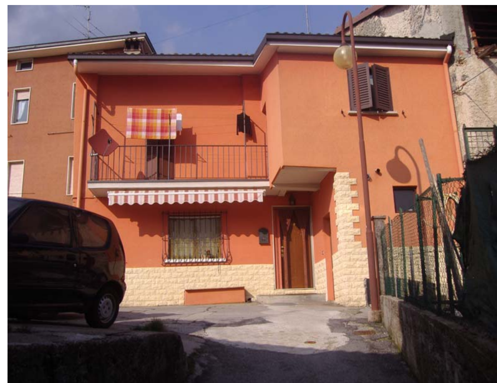
DOCUMENTAZIONE FOTOGRAFICA VISTA panoramica di contesto
