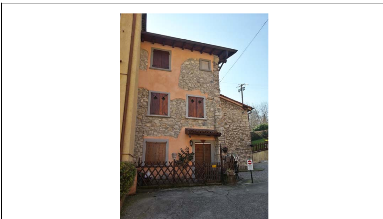
DOCUMENTAZIONE FOTOGRAFICA VISTA panoramica di contesto
