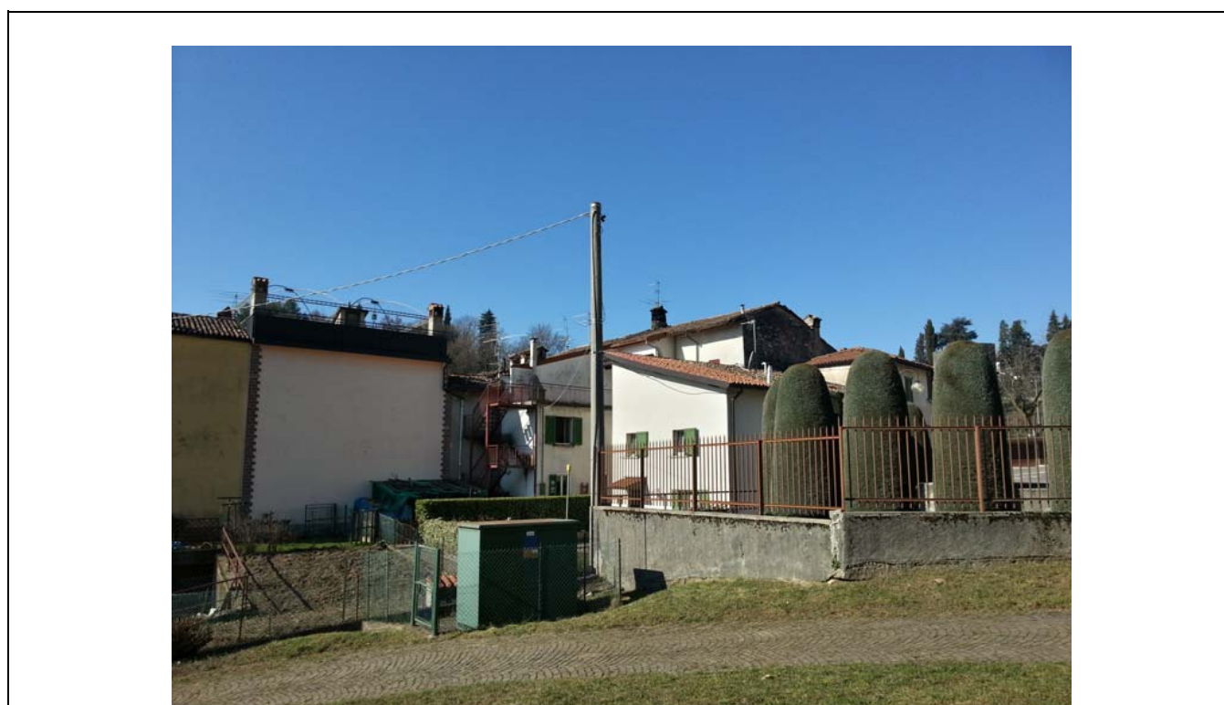
DOCUMENTAZIONE FOTOGRAFICA VISTA panoramica di contesto
