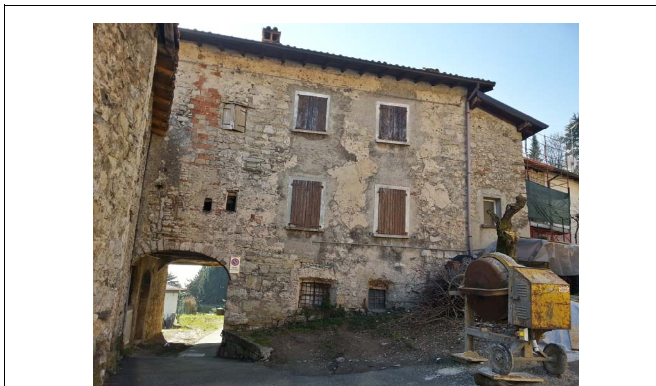
DOCUMENTAZIONE FOTOGRAFICA VISTA panoramica di contesto
