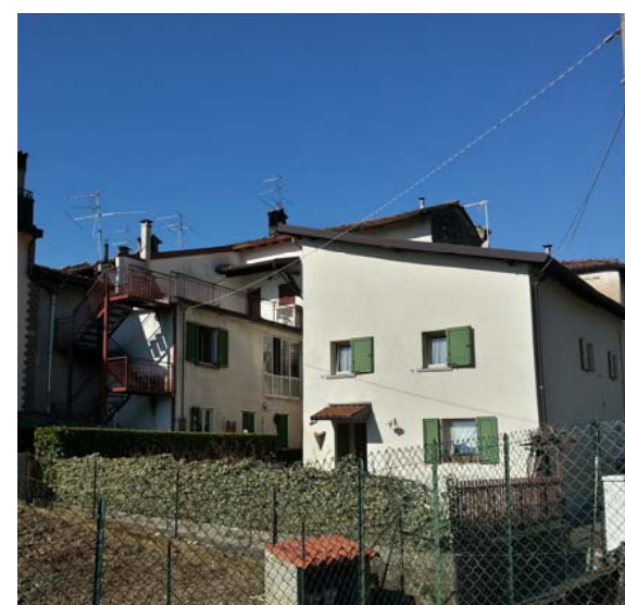
DOCUMENTAZIONE FOTOGRAFICA VISTA panoramica di contesto
