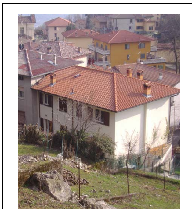
DOCUMENTAZIONE FOTOGRAFICA VISTA panoramica di contesto
