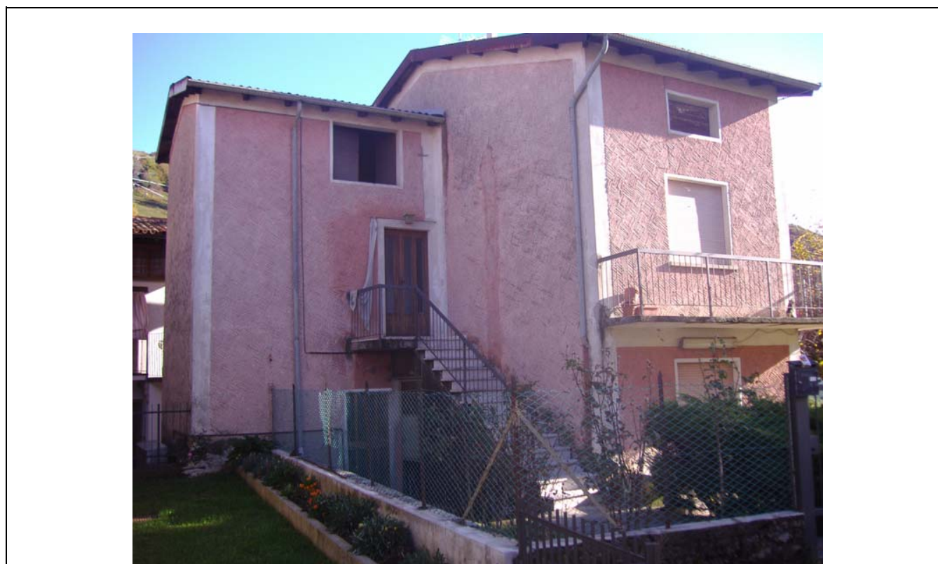
DOCUMENTAZIONE FOTOGRAFICA VISTA panoramica di contesto
