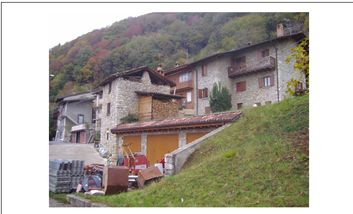
DOCUMENTAZIONE FOTOGRAFICA VISTA panoramica di contesto
