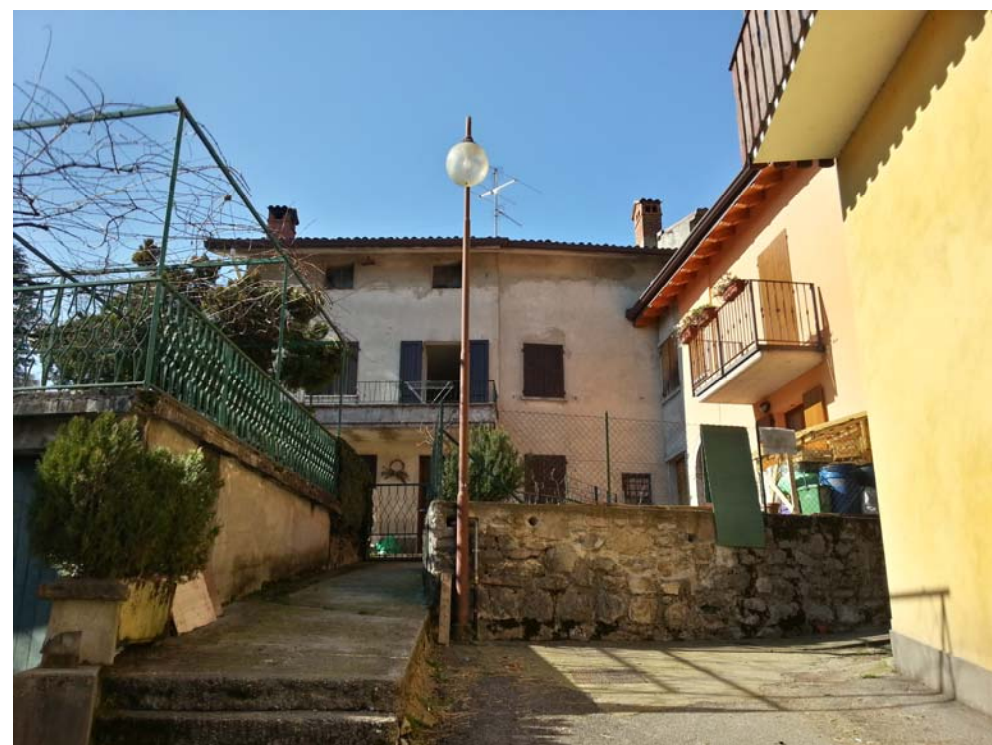
DOCUMENTAZIONE FOTOGRAFICA VISTA panoramica di contesto
