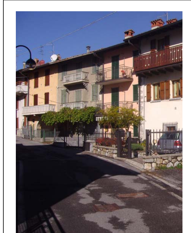
DOCUMENTAZIONE FOTOGRAFICA VISTA panoramica di contesto
