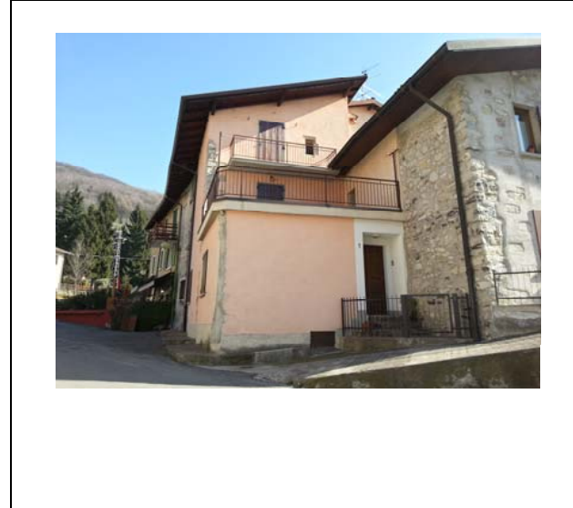
DOCUMENTAZIONE FOTOGRAFICA VISTA panoramica di contesto
