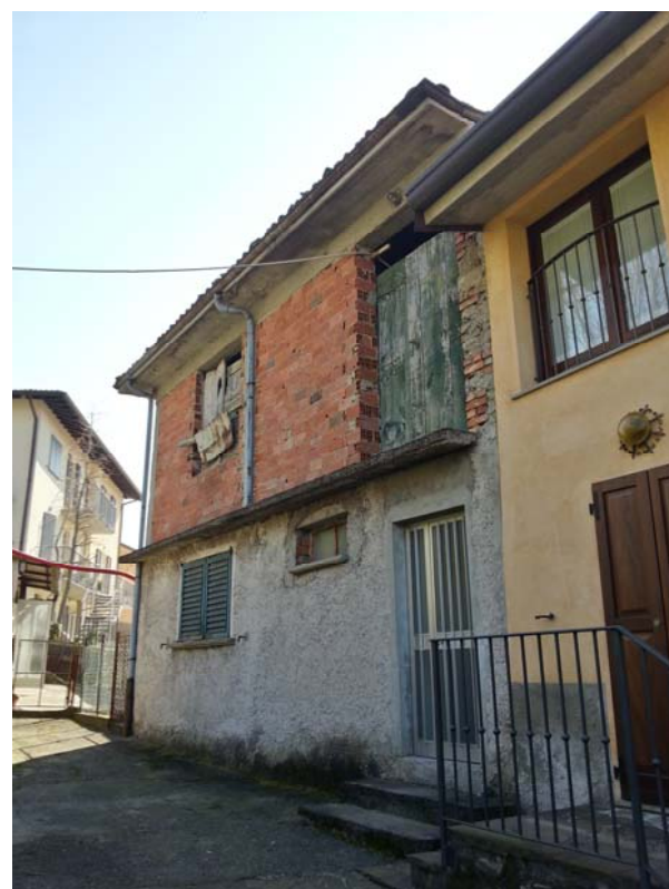
DOCUMENTAZIONE FOTOGRAFICA VISTA panoramica di contesto
