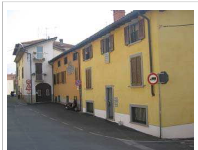
DOCUMENTAZIONE FOTOGRAFICA Vista panoramica di contesto
