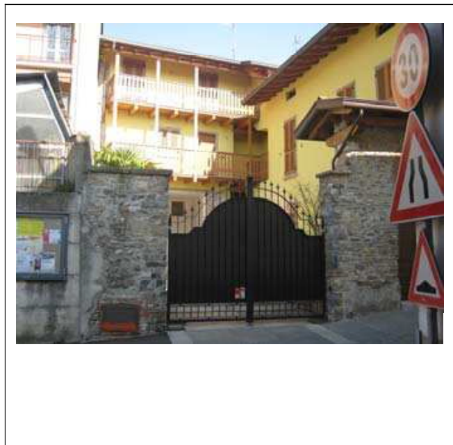
DOCUMENTAZIONE FOTOGRAFICA Vista panoramica di contesto
