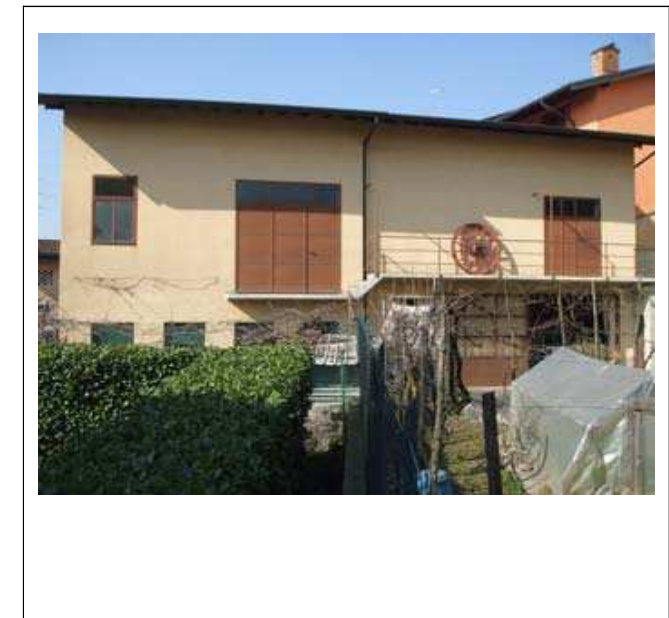
DOCUMENTAZIONE FOTOGRAFICA Vista panoramica di contesto
