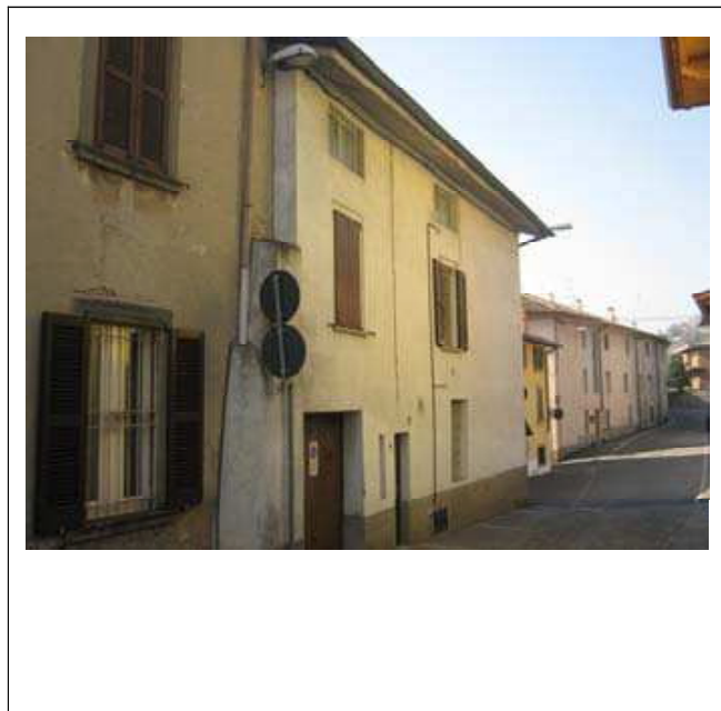
DOCUMENTAZIONE FOTOGRAFICA Vista panoramica di contesto
