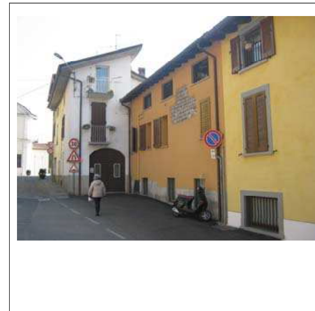
DOCUMENTAZIONE FOTOGRAFICA Vista panoramica di contesto
