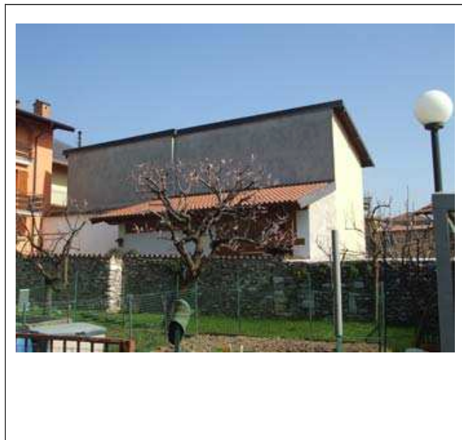
DOCUMENTAZIONE FOTOGRAFICA Vista panoramica di contesto
