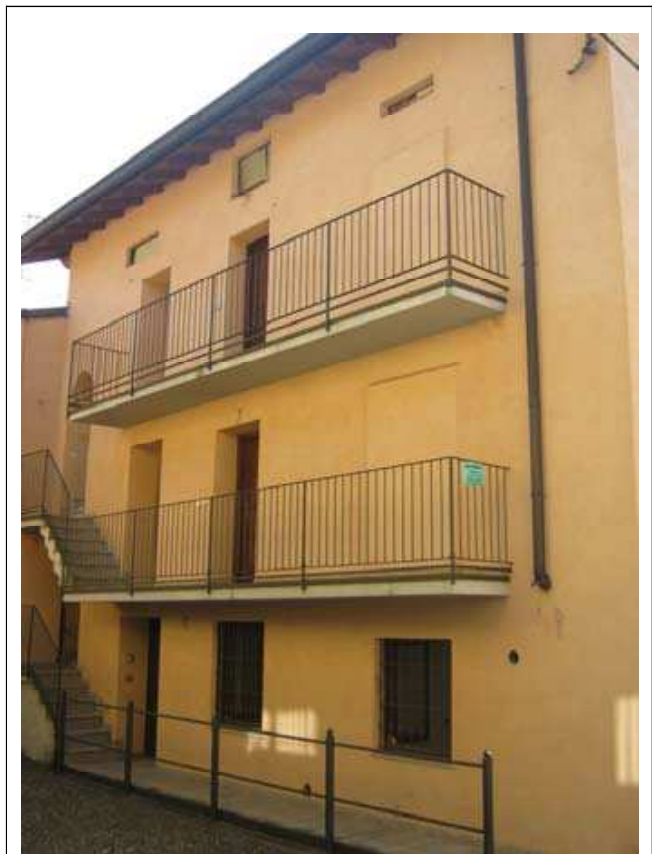
DOCUMENTAZIONE FOTOGRAFICA Vista panoramica di contesto
