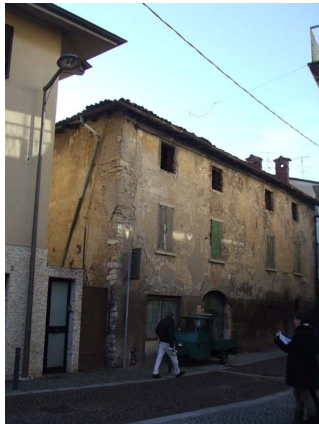
DOCUMENTAZIONE FOTOGRAFICA Vista panoramica di contesto
