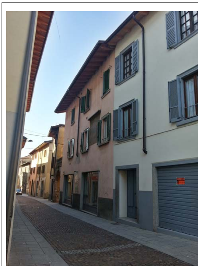
DOCUMENTAZIONE FOTOGRAFICA Vista panoramica di contesto
