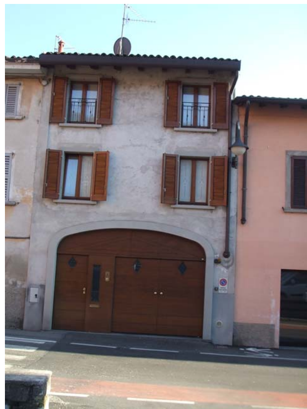
DOCUMENTAZIONE FOTOGRAFICA Vista panoramica di contesto
