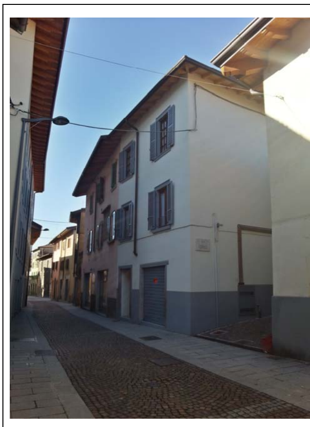
DOCUMENTAZIONE FOTOGRAFICA Vista panoramica di contesto
