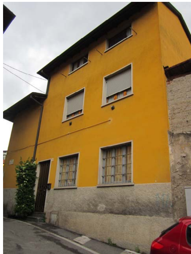
DOCUMENTAZIONE FOTOGRAFICA Vista panoramica di contesto
