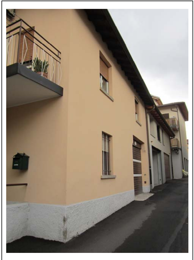
DOCUMENTAZIONE FOTOGRAFICA Vista panoramica di contesto
