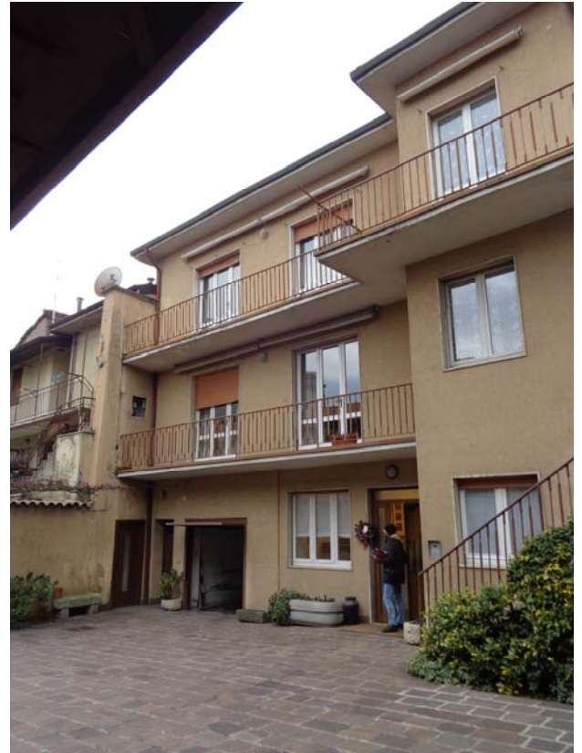
DOCUMENTAZIONE FOTOGRAFICA Vista panoramica di contesto
