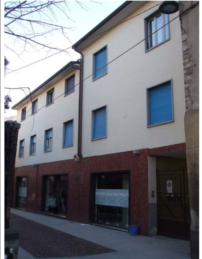
DOCUMENTAZIONE FOTOGRAFICA Vista panoramica di contesto
