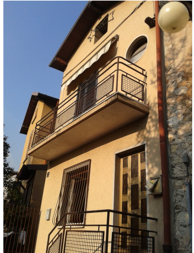
DOCUMENTAZIONE FOTOGRAFICA Vista panoramica di contesto
