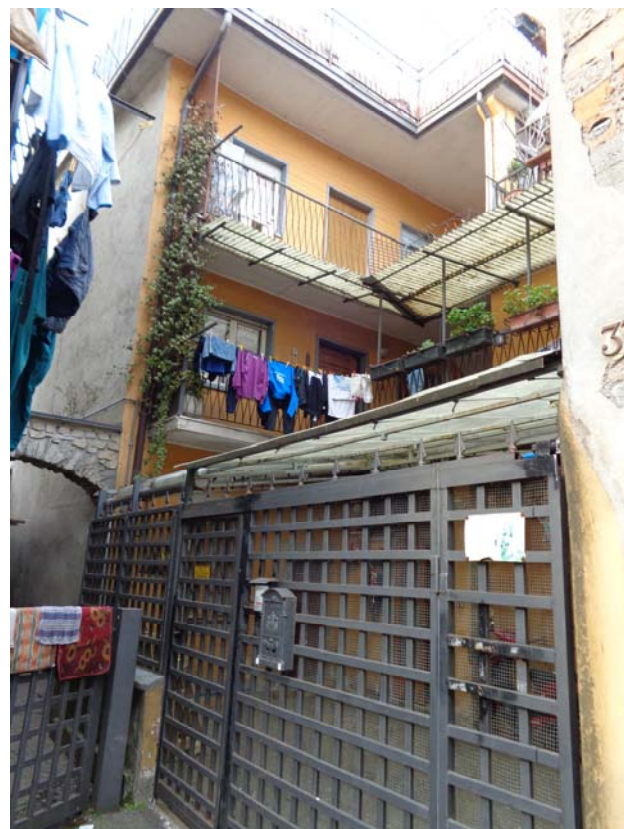
DOCUMENTAZIONE FOTOGRAFICA Vista panoramica di contesto
