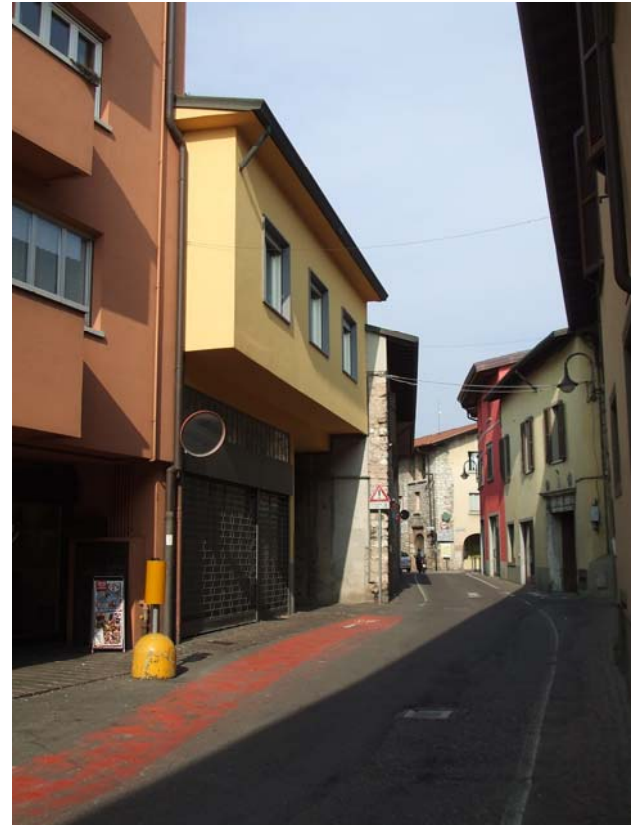
DOCUMENTAZIONE FOTOGRAFICA Vista panoramica di contesto
