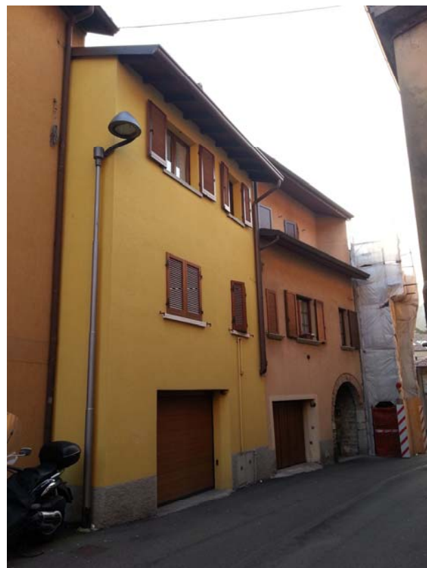
DOCUMENTAZIONE FOTOGRAFICA Vista panoramica di contesto
