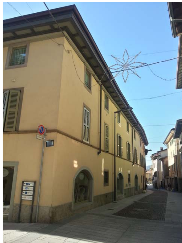
DOCUMENTAZIONE FOTOGRAFICA Vista panoramica di contesto
