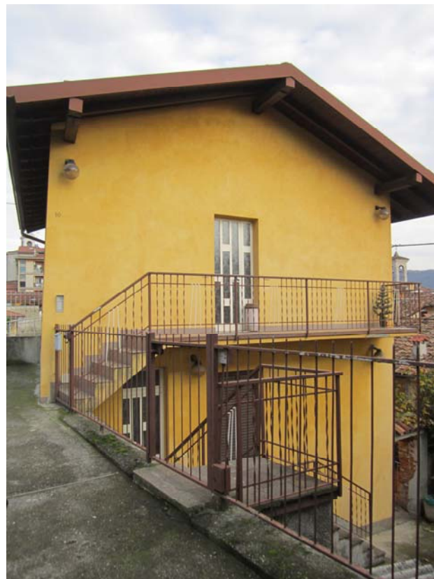
DOCUMENTAZIONE FOTOGRAFICA Vista panoramica di contesto
