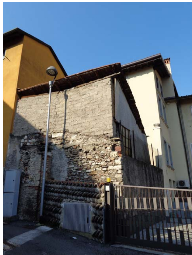
DOCUMENTAZIONE FOTOGRAFICA Vista panoramica di contesto
