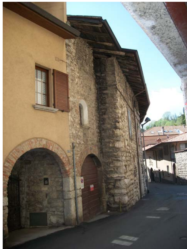
DOCUMENTAZIONE FOTOGRAFICA Vista panoramica di contesto
