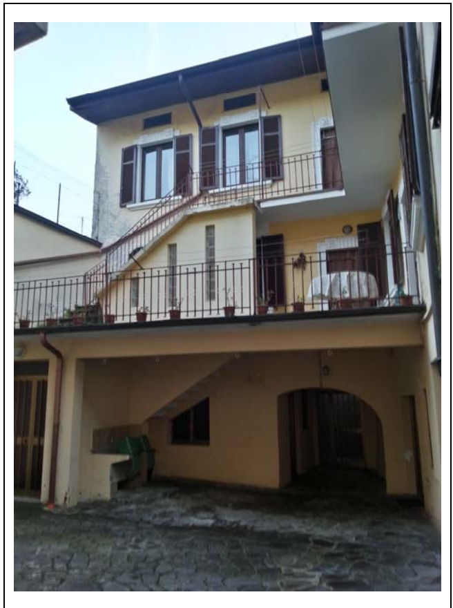
DOCUMENTAZIONE FOTOGRAFICA Vista panoramica di contesto
