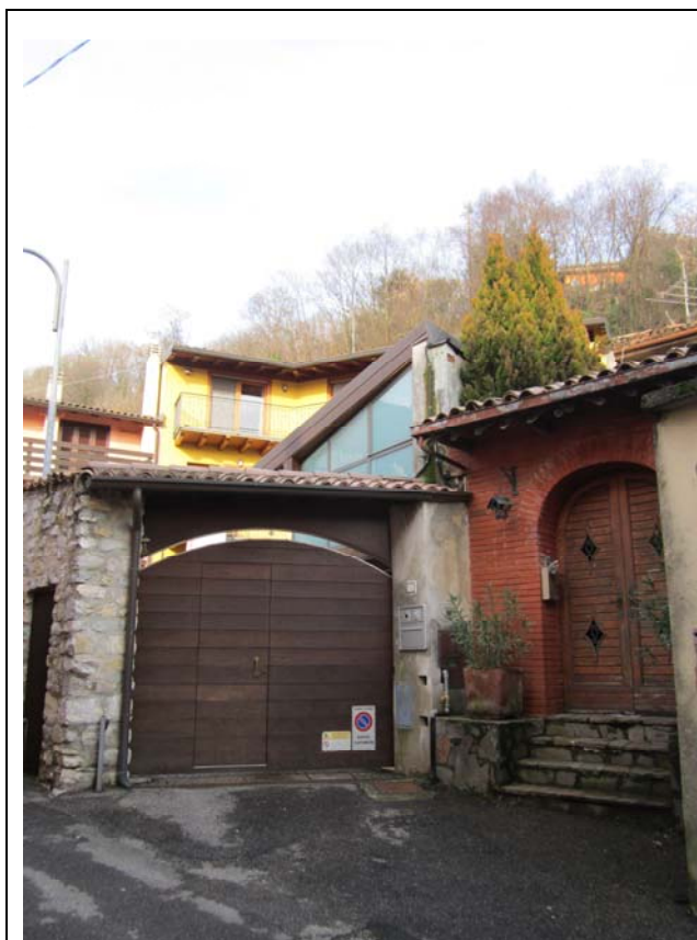
DOCUMENTAZIONE FOTOGRAFICA Vista panoramica di contesto
