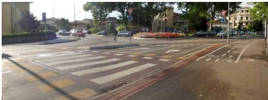
rotatoria completamente circondata da percorso bidirezionale - Padova
