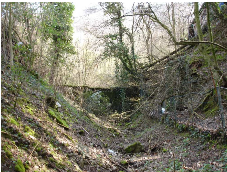
Foto 26: briglia in cls realizzata a quota 330 m slm
