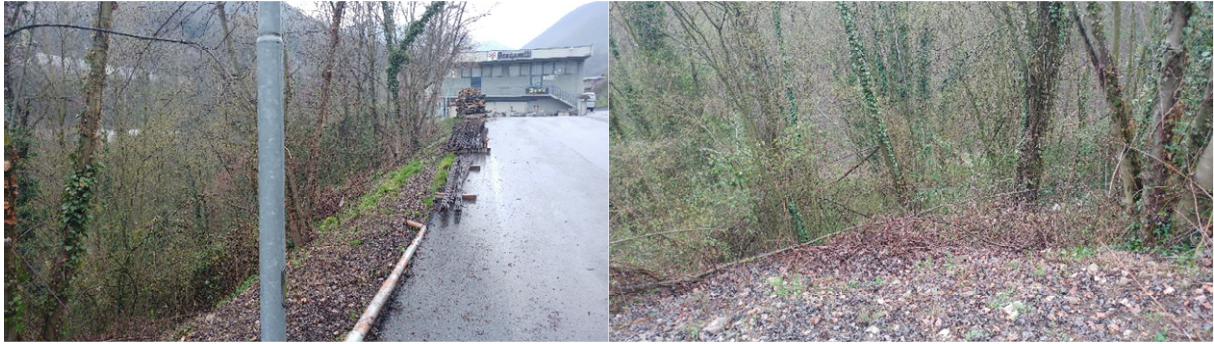
Foto 29: tratto incassato del T. Carso in prossimità del capannone Bergamelli
