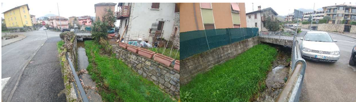
Foto 44: Tratto del T. Luio all'altezza del ponte a quota 305 m slm. Vista da monte a sx e vista da valle a dx. A monte del ponte le esondazioni sono possibili solo sul lato destro (comune di Alzano). Il tratto si presenta fortemente sovralluvionato e la luce del ponte fortemente ridotta. Una ulteriore riduzione della luce attuale potrebbe determinare esondazioni verso le strade limitrofe anche in comune di Nembro (a valle del ponte).
