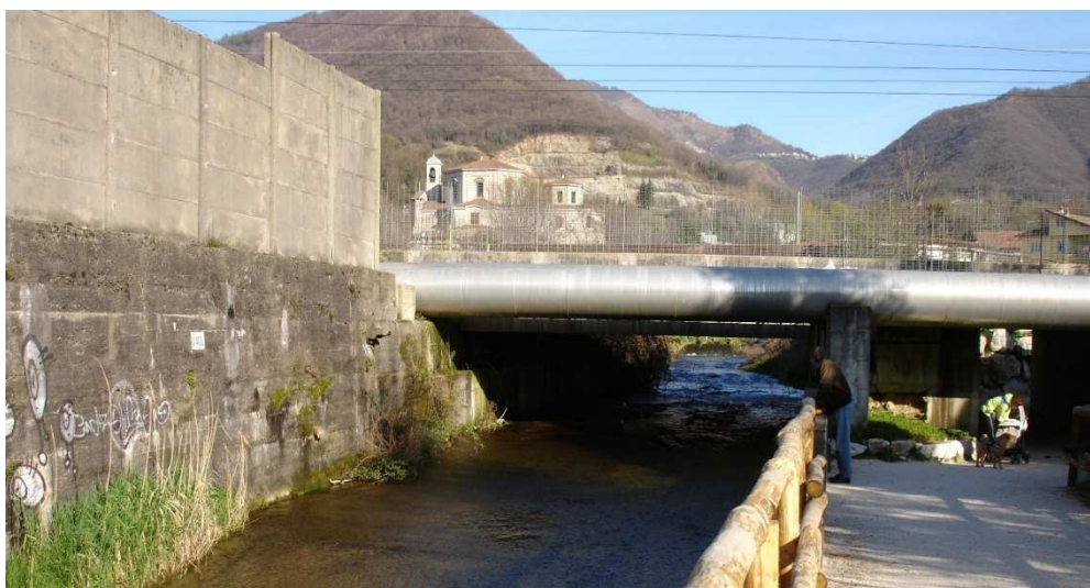
Foto 40: passerella con sezione critica, presso il T. Carso all'altezza del sovrappasso della Roggia Morlana.
