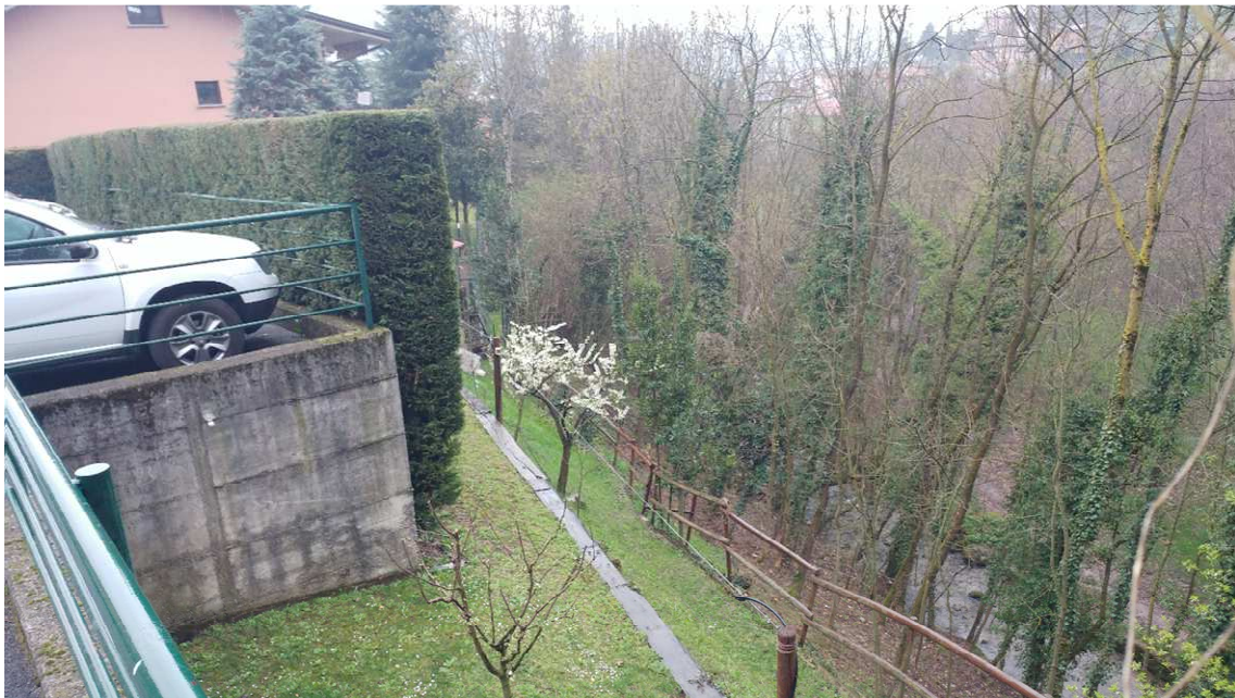
Foto 30: tratto incassato del T. Carso in prossimità del capannone Bergamelli e delle villette di Via Morali
