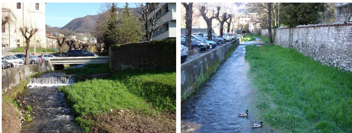
Foto 34: tratto del T. Carso lungo via Colleoni con la passerella "Centro Odontoiatrico Daina"
