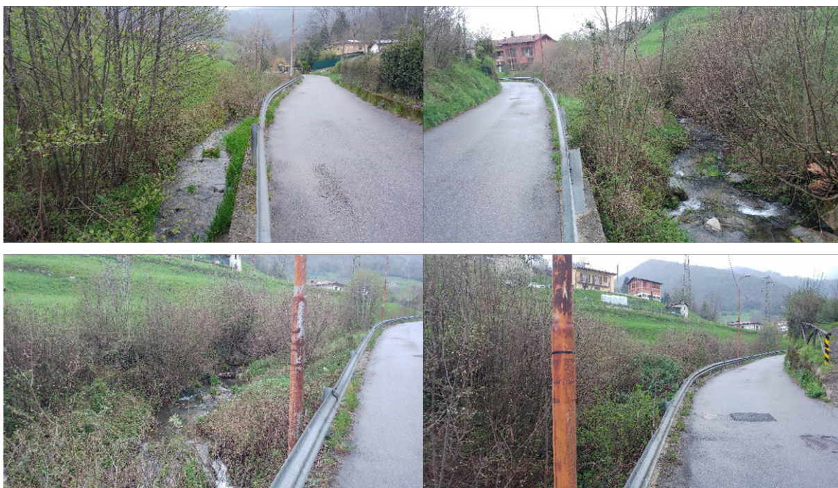
Foto 42: Tratto del T. Luio a valle del ponte a quota 330 m slm. Vista da valle a sx e vista da monte a dx. La strada che costeggia il torrente (in comune di Nembro) è stata inserita cautelativamente in zona esondabile soprattutto nel caso si verificassero ostruzioni del corso d'acqua ad opera di detriti vegetali, tronchi e trasporto solido in genere. Si tratta di un tratto caratterizzato da una rilevante vegetazione arbustiva che potrebbe costituire ostacolo al deflusso soprattutto in caso di rilevante trasporto solido
