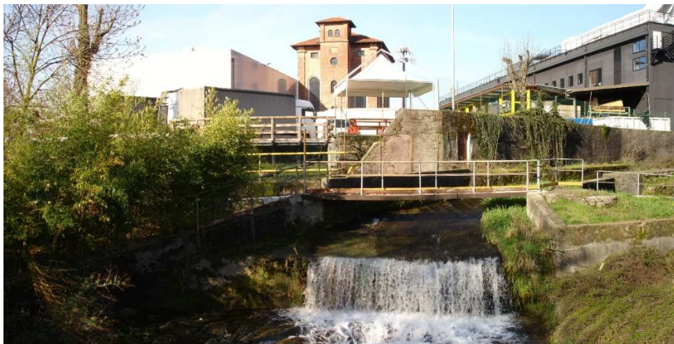
Foto 39: attraversamento o TEB e muri spondali della ditta Persico
