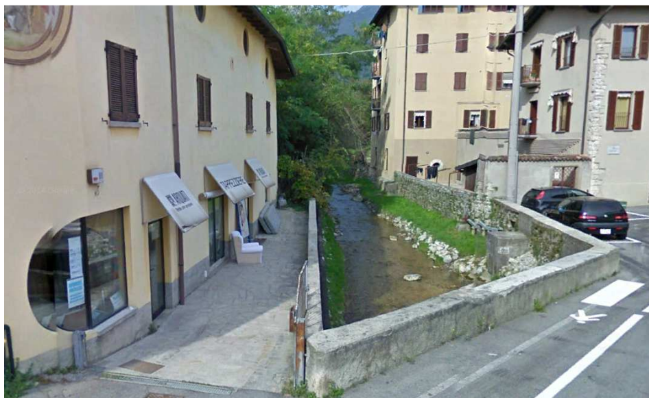
Foto 32: tratto del T. Carso a monte dell'attraversamento di Via San Martino
