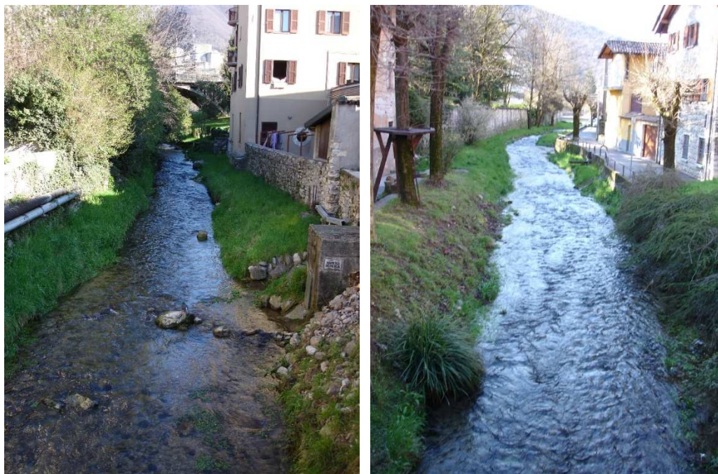
Foto 33: tratto del T. Carso a monte e a valle dell'attraversamento di Via San Martino
