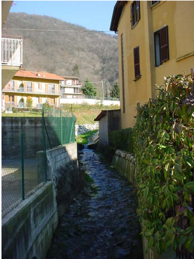
Foto 1: tratto a monte S.P. 65
