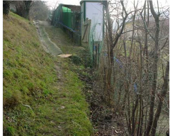
Foto 2: canaletta in cls
