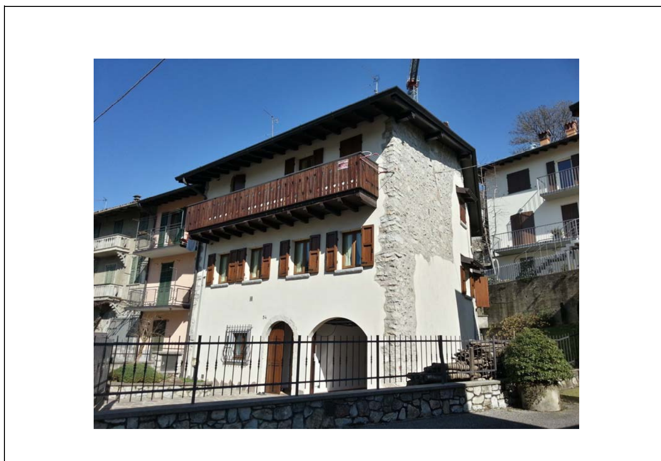
DOCUMENTAZIONE FOTOGRAFICA VISTA panoramica di contesto
