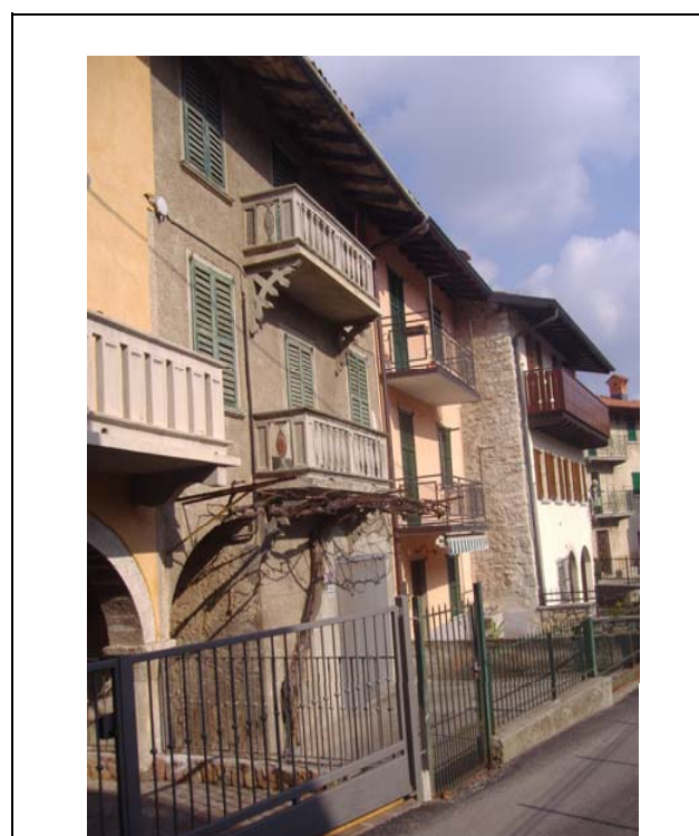
DOCUMENTAZIONE FOTOGRAFICA VISTA panoramica di contesto
