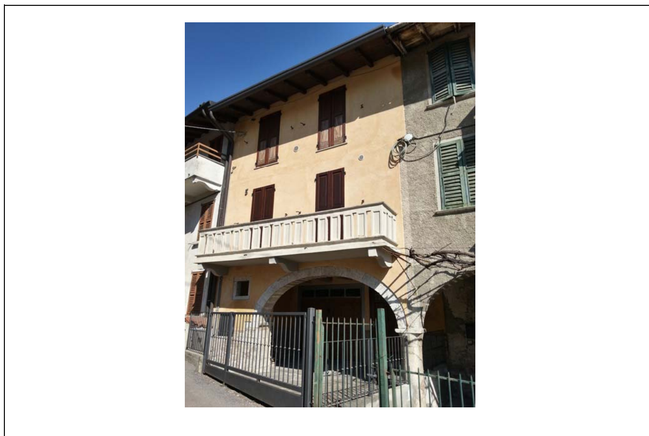
DOCUMENTAZIONE FOTOGRAFICA VISTA panoramica di contesto
