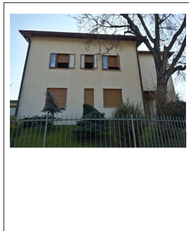
DOCUMENTAZIONE FOTOGRAFICA VISTA panoramica di contesto
