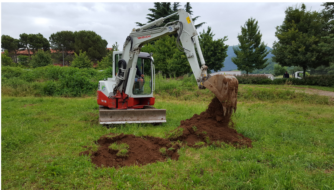
Foto n. 9: realizzazione del pozzetto geognostico A4
