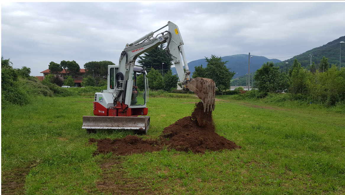
Foto n. 7: realizzazione del pozzetto geognostico A3
