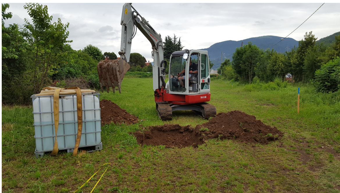
Foto n. 5: realizzazione del pozzetto geognostico A2
