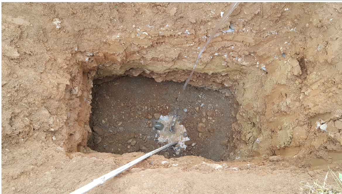
Foto n. 13: immissione dell'acqua necessaria alla conseguente prova di permeabilità a carico variabile, eseguita nel pozzetto A3
