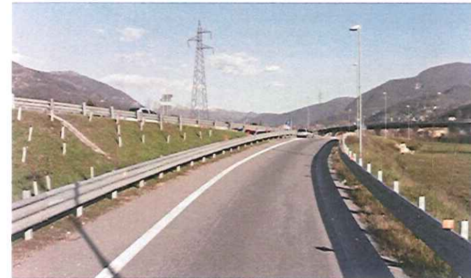
Foto 12 – S12: rampa di accesso alla SP35dir – direzione est
