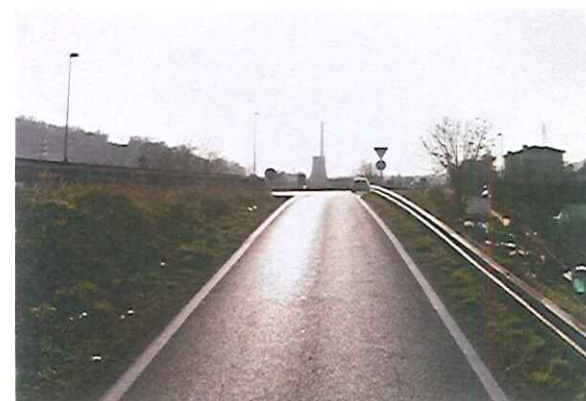
Foto 2 – S2: rampa di accesso alla SP35 – direzione ovest
