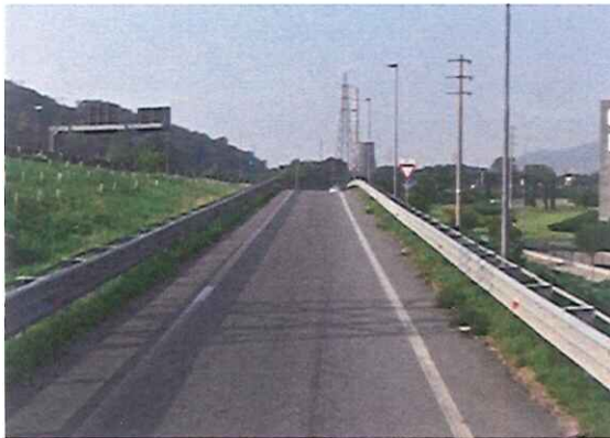
Foto 9 – S9: rampa di accesso alla SP35dir – direzione ovest
