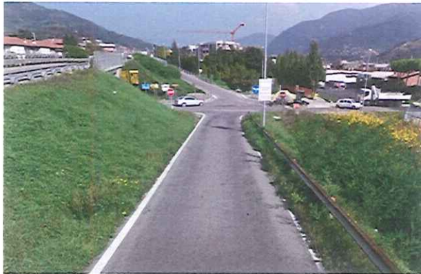
Foto 3 – S3: rampa di uscita dalla SP35 – direzione est
