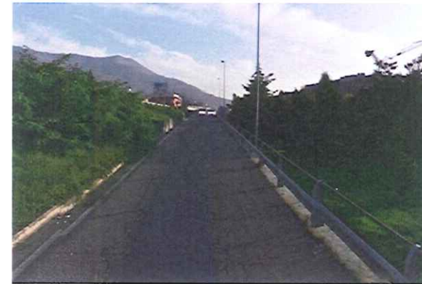
Foto 4 – S4: rampa di accesso alla SP35 – direzione est
