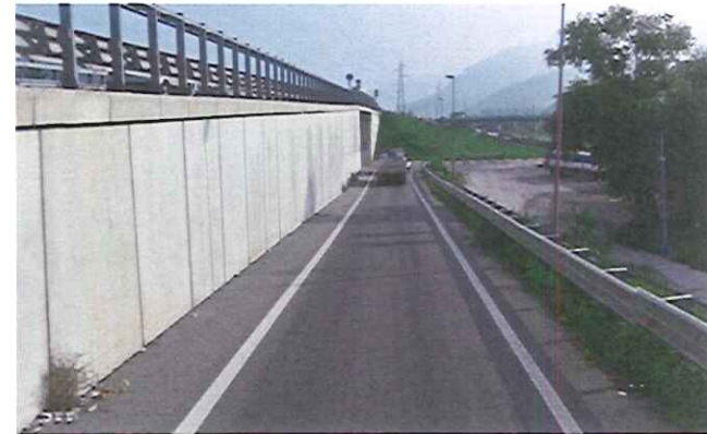
Foto 10 – S10: rampa di uscita dalla SP35dir – direzione est
