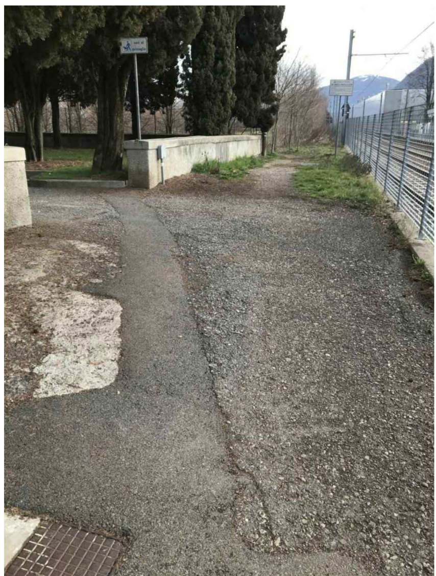
02 - vista del percorso esistente ingresso
