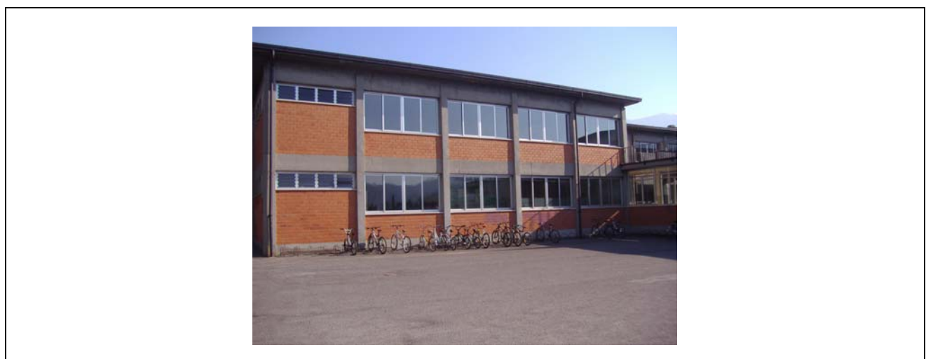
Link album fotografico ..\fotografie\ISTRUZIONE\IS_007A_scuola secondaria di primo grado Istituto comprensivo enea talpino
