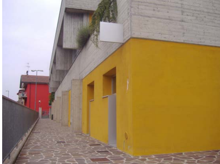
Link album fotografico ..\fotografie\ISTRUZIONE\IS_008A_palestra scuola primaria elementare Crespi via San Faustino
