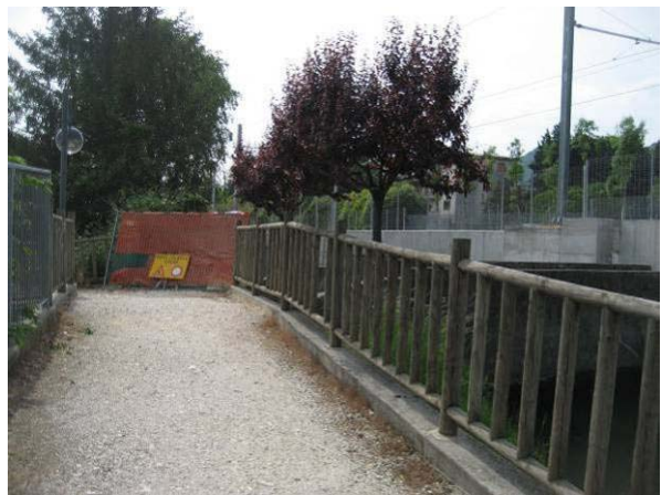
... fino al blocco costituito dalla TEB
