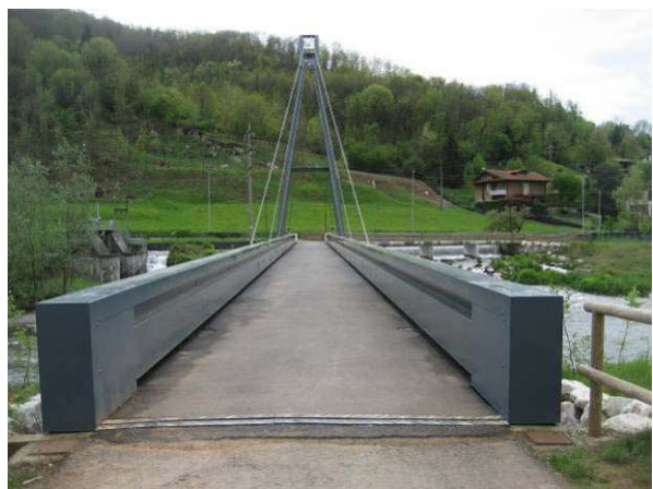
La Passerella verso la sponda sinistra
