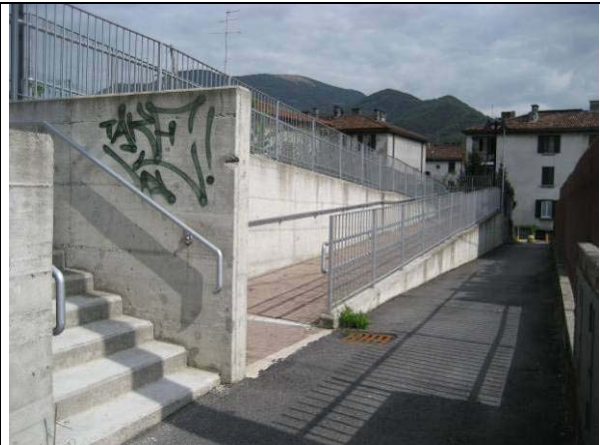
Particolari delle rampe
