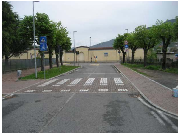
L'attraversamento protetto verso il cimitero
