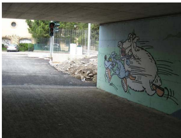
L'altro sottopasso della superstrada che porta all'attraversamento TEB
