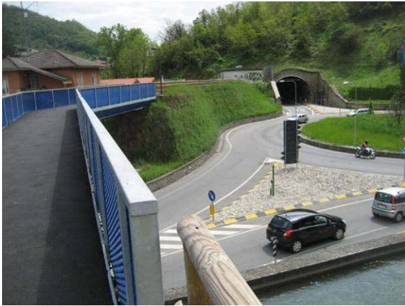
La passerella sulla provinciale 85
