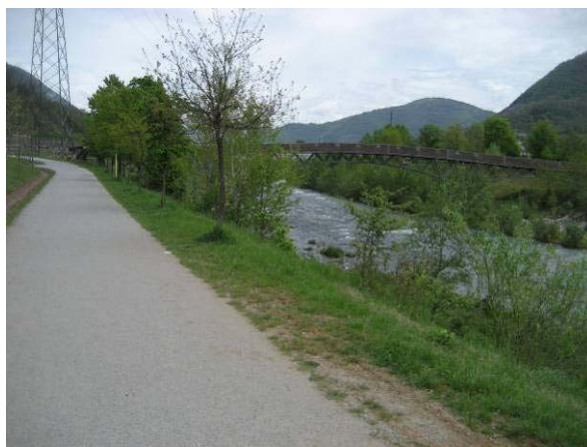
La ciclabile sulla sponda del fiume direzione nord
