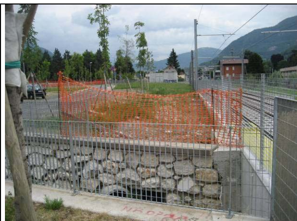
Lungo i binari verrà realizzata la continuità del percorso verso la fermata Teb
