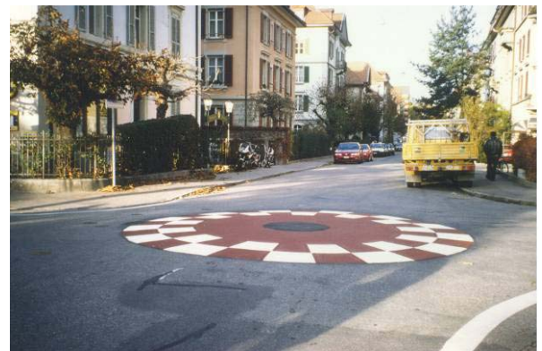
Intersezione con calotta di bitume
