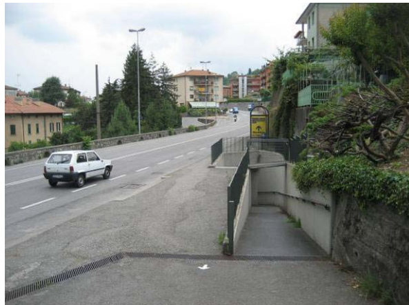
Lo sbocco dall'alto del sottopasso
