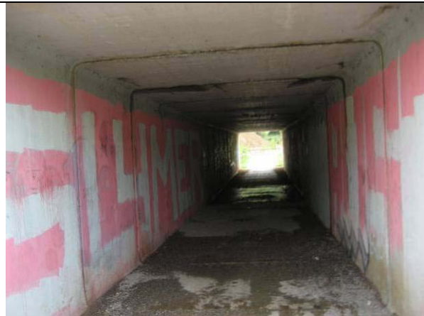
Il sottopasso della superstrada
