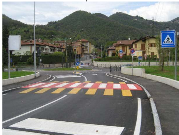
Un attraversamento pedonale leggermente rialzato
