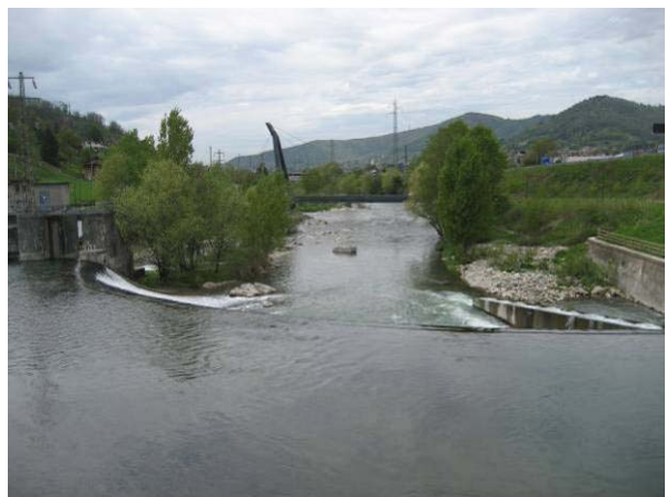
La nuova passerella e la presa del canale
