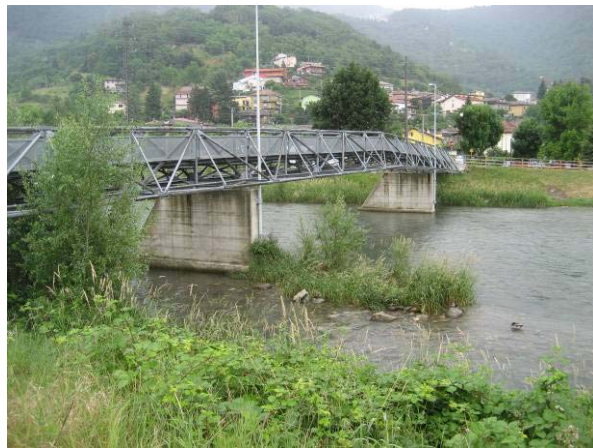
la Passerella Honnegher
