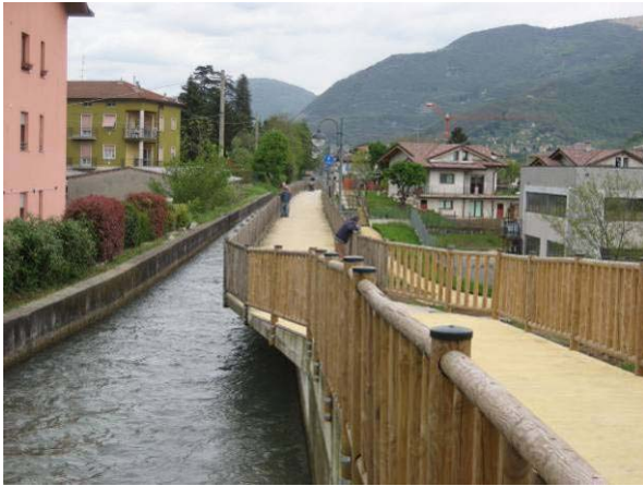
Imbocco della ciclabile della Seriola da Alzano
