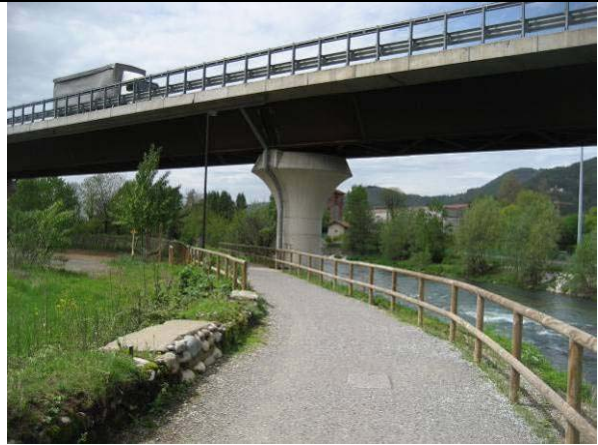
L'autostrada in viadotto
