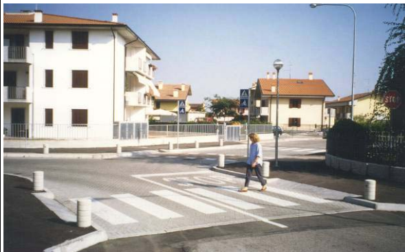
Attraversamento pedonale con restringimento e cambio della pavimentazione
