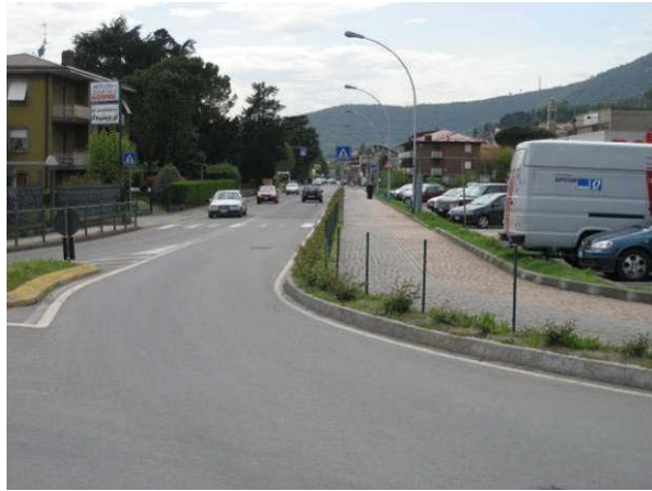
La ciclabile su via Roma che viene da Alzano, è una delle poche ciclabili a norma Migliorare la segnaletica
