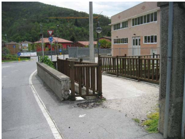
Imbocco da via Marconi Dare continuità su via Marconi
