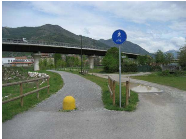
In prossimità del ponte storico
