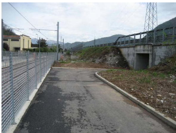
Il sottopasso della superstrada
