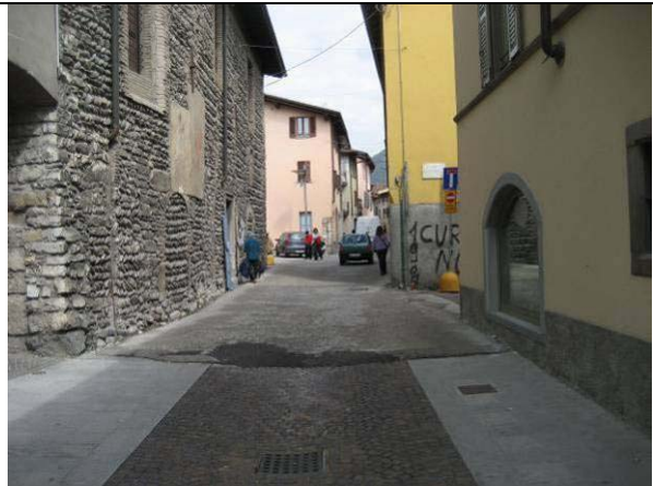
Termina la nuova pavimentazione in corrispondenza di via Moscheni
