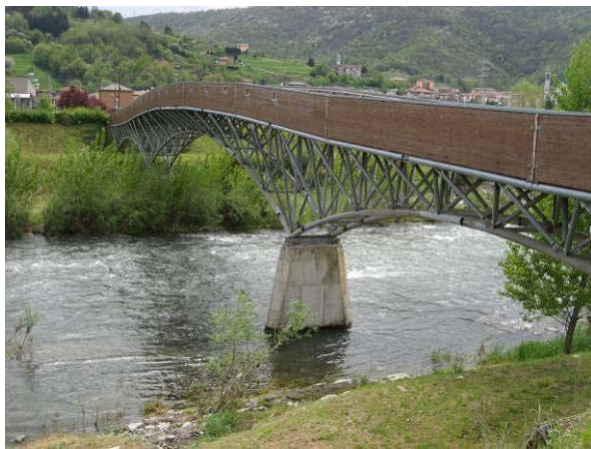
Vista laterale della passerella
