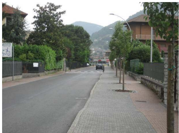
con la ciclabile contigua al marciapiede
