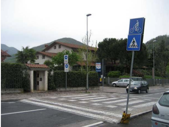
Attraversamento su platea rialzata di via acque dei buoi
