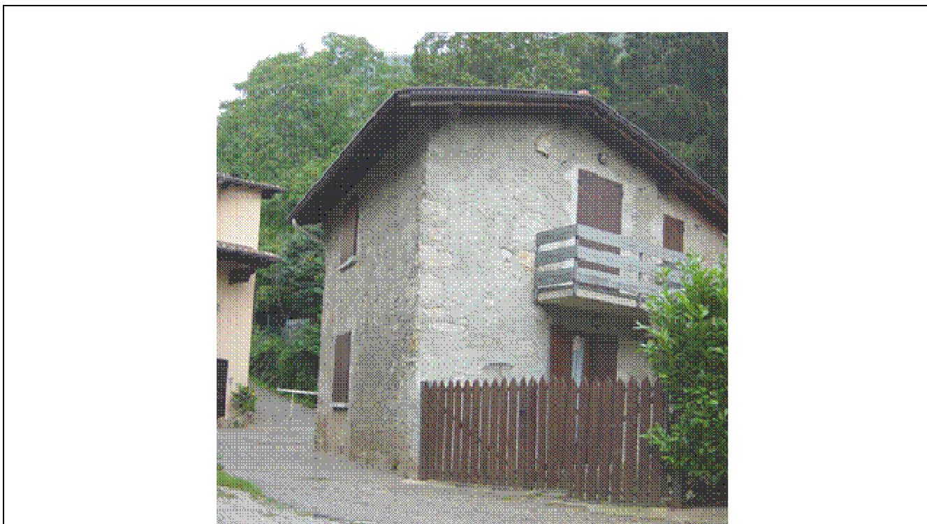
DOCUMENTAZIONE FOTOGRAFICA VISTA panoramica di contesto
