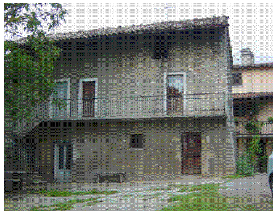
DOCUMENTAZIONE FOTOGRAFICA VISTA panoramica di contesto
