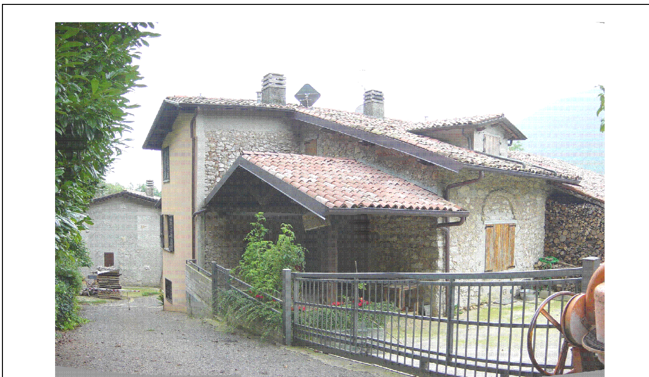
DOCUMENTAZIONE FOTOGRAFICA VISTA panoramica di contesto
