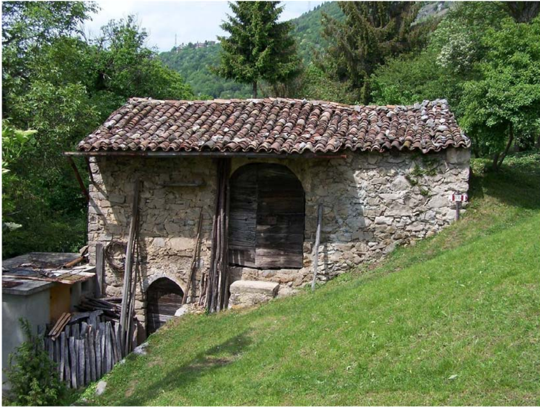
Figura 5. Cascina in località Pradale – Trevasco
