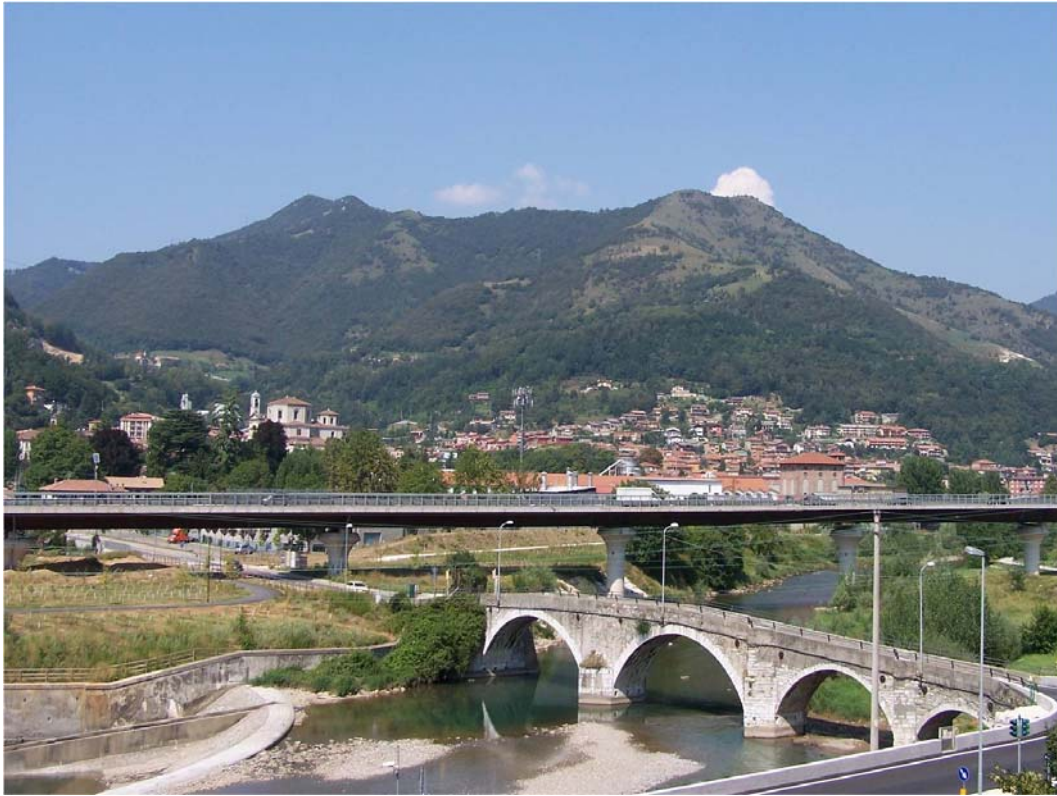
Figura 1.foto generica dell'ambiente piazza-Trevasco – vista da Magasali
