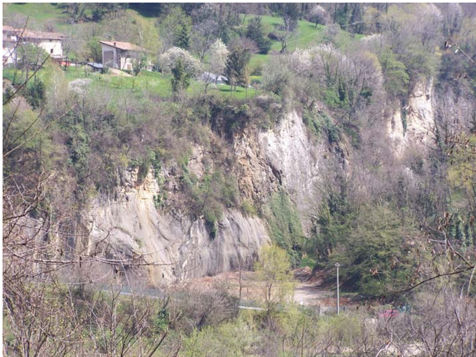
Figura 8. Parete di cava - Trevasco
