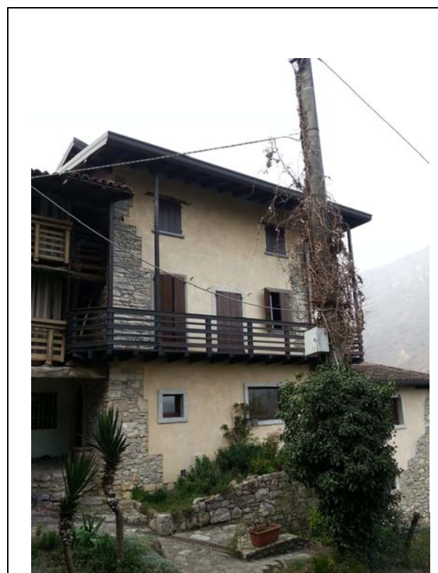
DOCUMENTAZIONE FOTOGRAFICA VISTA panoramica di contesto
