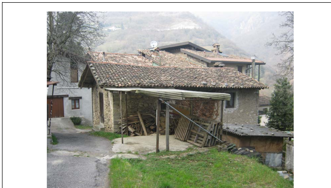
DOCUMENTAZIONE FOTOGRAFICA VISTA panoramica di contesto
