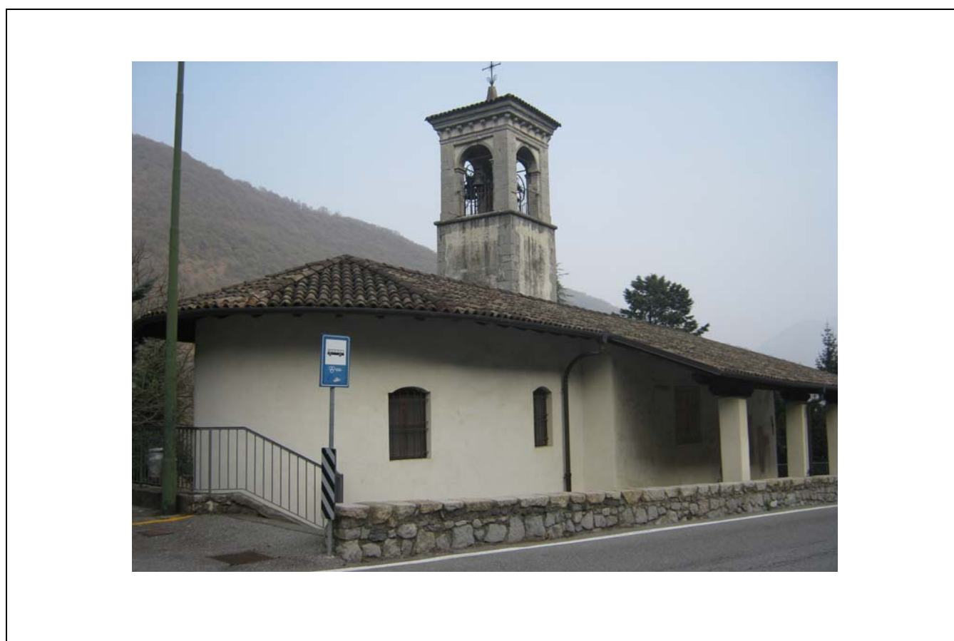
DOCUMENTAZIONE FOTOGRAFICA VISTA panoramica di contesto
