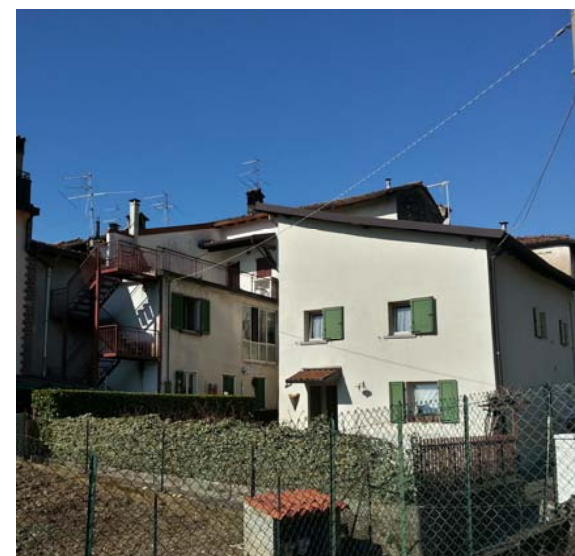
DOCUMENTAZIONE FOTOGRAFICA VISTA panoramica di contesto
