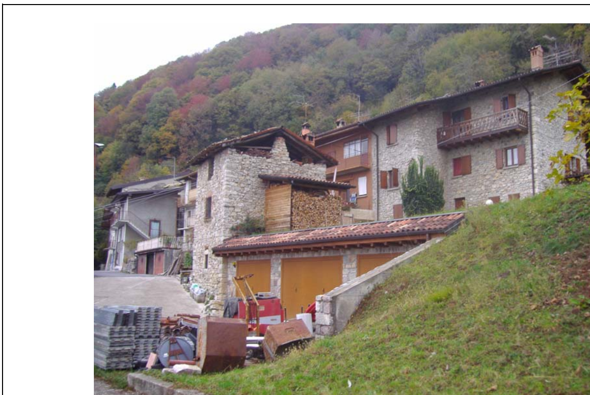
DOCUMENTAZIONE FOTOGRAFICA VISTA panoramica di contesto
