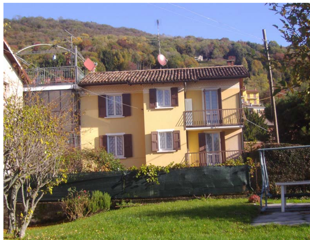
DOCUMENTAZIONE FOTOGRAFICA VISTA panoramica di contesto
