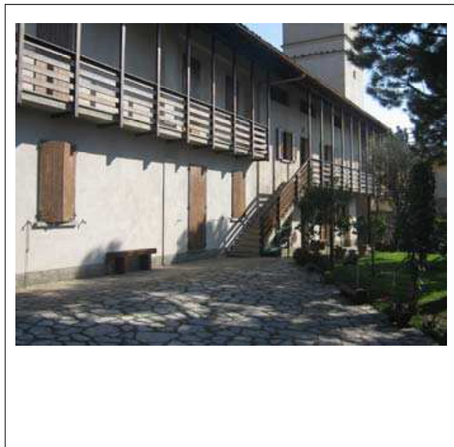
DOCUMENTAZIONE FOTOGRAFICA Vista panoramica di contesto
