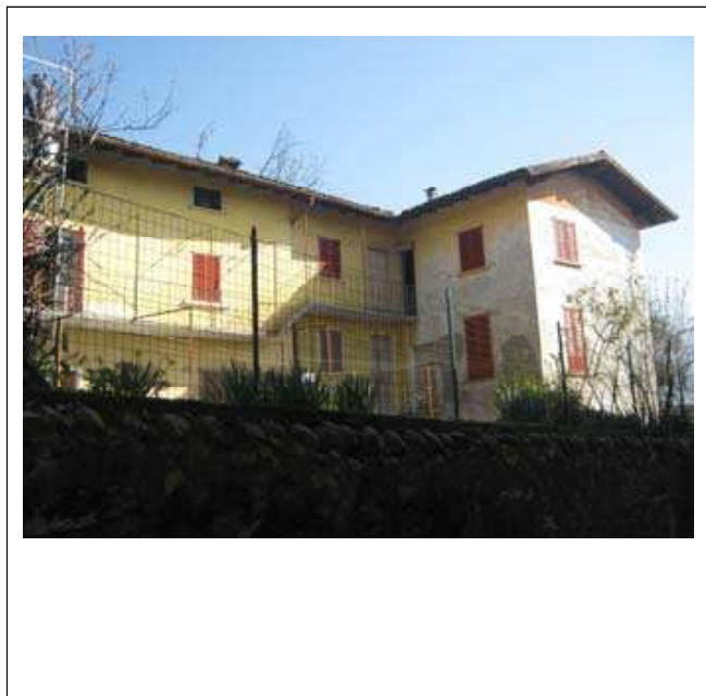
DOCUMENTAZIONE FOTOGRAFICA Vista panoramica di contesto
